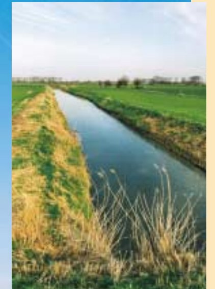
Op de zijlopen in het broekengebied zijn een aantal pompen geplaatst die aangedreven worden door de wind. Ze hevelen het water van de polderwaterlopen over naar de Poperingevaart. Er is geen migratie van vissen mogelijk langs of door deze kunstwerken.
