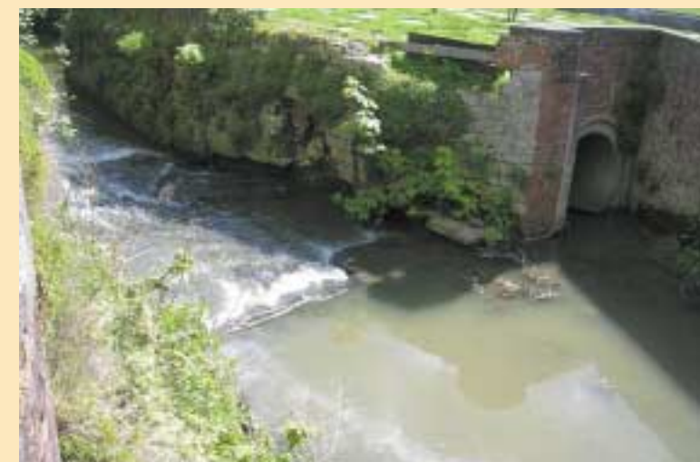
Vismigratieknelpunt aan het voormalige sluishuisje te Poperinge.
