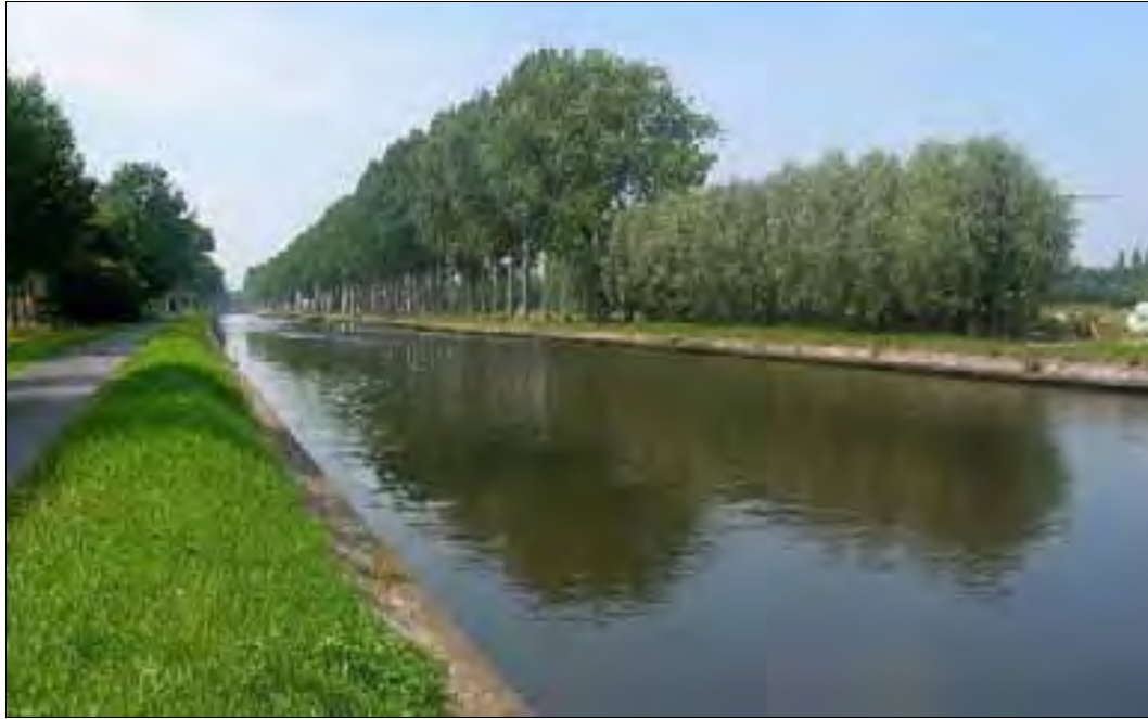
Foto 14. De oeververdediging tussen Moerbrugge en Brugge bestaat vooral uit een damwand met een betonkopbalk. Deze oeververdediging heeft nauwelijks ecologische waarde vermits de vestiging van oevervegetatie niet mogelijk is waardoor er ook geen foerageer-, broed- of rustmogelijkheden zijn voor allerlei dieren. Bovendien kunnen dieren die in het water terecht komen verdrinken omdat fauna-uitstapplaatsen ontbreken. Ook voor eventuele menselijke drenkelingen is deze situatie niet zonder gevaar. Op termijn is een meer natuurvriendelijke oeverinrichting wenselijk. Om visueel-landschappelijke redenen kan ondertussen geopteerd worden om overhangende braamstruwelen, graszoden en mosbegroeiingen op de betonkopbalken niet meer systematisch te verwijderen.
