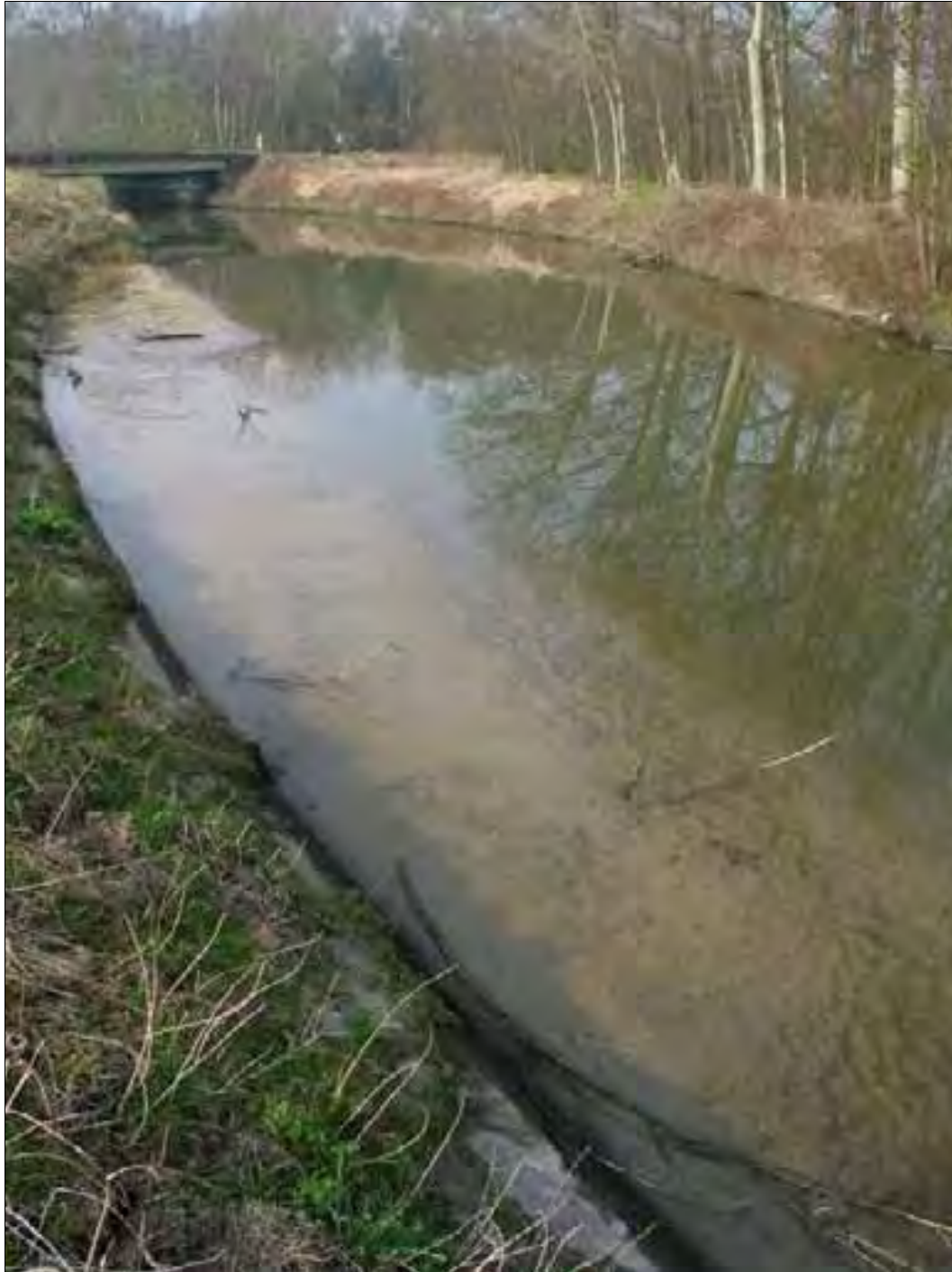
Foto 121. Ter hoogte van de monding in het kanaal Gent-Brugge is de Rivierbeek in het verleden gekanaliseerd en van natuuronvriendelijke, betonnen oevers voorzien. In dynamisch evenwicht met het bovendebiet en het sedimenttransport neemt de beek spontaan terug een meanderende loop aan binnen dit betonnen keurslijf. Deze meanderende loop wordt ingenomen volgens de natuurlijke breedte, waardoor zandige sedimentbanken van wisselende breedte tegen de betonnen oever worden afgezet. Dit schept perspectieven voor een gedeeltelijk natuurherstel, zonder hoge kosten. Voorwaarde is wel dat de spontane zandafzettingen niet worden weggegraven of dat deze ingreep beperkt blijft tot de komvormig verbrede monding in het kanaal. Om sedimenttransport naar het kanaal te beperken kunnen eventueel maatregelen genomen worden om de sedimentvracht zo veel mogelijk stroomopwaarts te laten sedimenteren. Het beheer van de waterloop dient hierbij te mikken op tragere stroomsnelheden (door vertraagde afvoer van overtollig neerslagwater en achterwege laten van beekruimingen) en herwaardering van de natuurlijke overstromingsgebieden, grachtenstelsels en (her)meanderingsprocessen.
