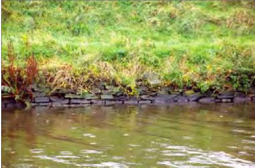
Foto 10. Tussen Durmen- en Aalterbrug is breuksteen, geplaatst in een min of meer regelmatige structuur, gebruikt als oeververdediging. Dergelijke oevers bezitten, in vergelijking met bv. losse steenbestortingen, weinig holtes waardoor de vegetatie aan de waterlijn vrij schaars is.
