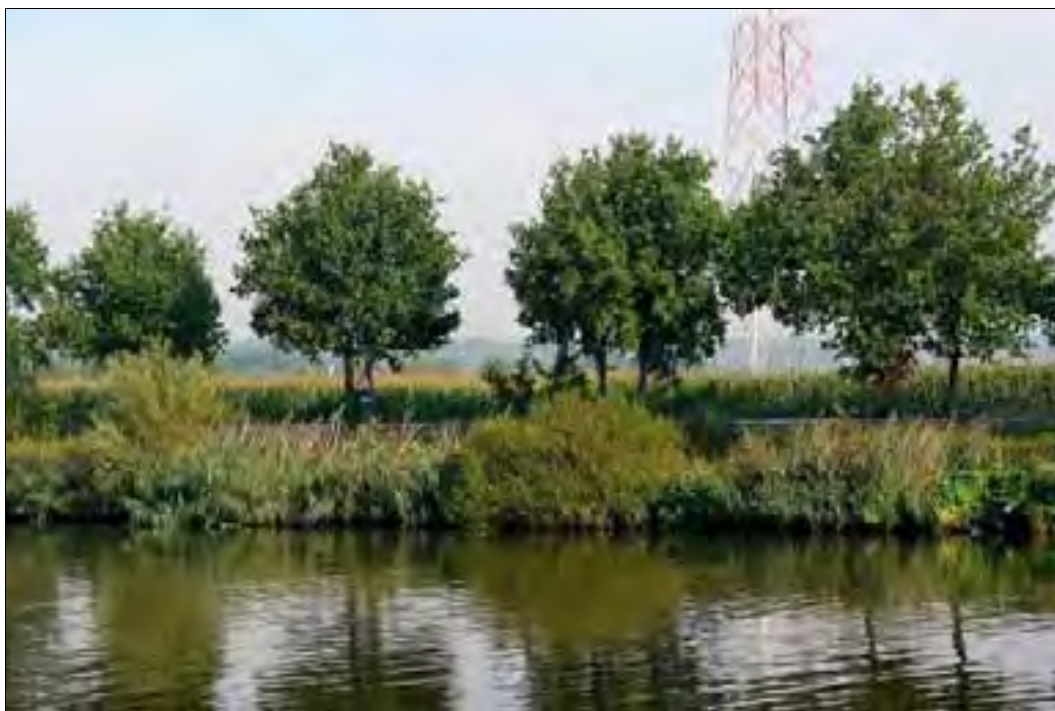
Foto 9. De linkeroever tussen het Duivelsputgemaal en Durmenbrug is verdedigd door grove schanskorven. De schanskorven worden er geleidelijk gekoloniseerd door een spontane wilgenopslag (bovenste foto) en oeverbegroeiing. Waar Riet reeds in de oever aanwezig waren, laten grove schanskorven een vrij snelle kolonisatie van oevervegetatie toe, zoals t.h.v. Durmenbrug (onderste foto). De struwelen en rietvegetaties dienen best zo veel mogelijk met rust te worden gelaten (en worden dus ook niet mee gemaaid bij bermbeheer). Hooguit kunnen de struwelen, waar nodig, in hakhout worden omgezet.
