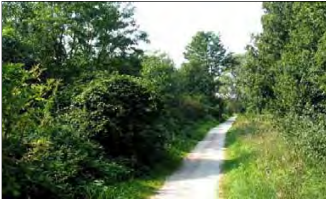
Foto 42. Ontsluiting voor intensieve fietsrecreatie hoeft niet steeds te gebeuren met beton of asfalt. Een natuurvriendelijker oplossing biedt een halfverharding met ternair zand, zoals ter hoogte van de Miseriebocht. Dergelijke wegen zijn landschappelijk aantrekkelijker dan asfalt- en betonwegen, ze geven minder schadelijke stoffen af naar het omgevend milieu en vormen een minder grote barrière voor ongewervelde bodemdieren. Op de foto zijn nog fraaie mantel-zoomvegetaties langs de weg te zien, die kunnen in stand worden gehouden door een cyclisch kap- en maaibeheer. Oprukkende exoten als Amerikaanse vogelkers en Robinia worden hier best verwijderd.
