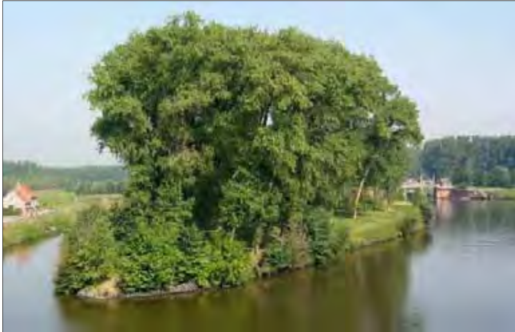
Foto 88. Aan de kruising van het kanaal Gent-Brugge en het Afleidingskanaal van de Leie is “het eiland” gelegen. Maatregelen die in het landinrichtingsplan worden voorgesteld zijn het vervangen van de populieraanplantingen door een mozaïek van streekeigen struiken en bomen, het voorzien van een picknickruimte en het plaatsen van een infobord over de historiek van beide kanalen. Op de zuidelijke tip (vooraan op de foto) en aan de westelijke kant (volgende foto) van “het eiland” komt een iepestruweel voor.
