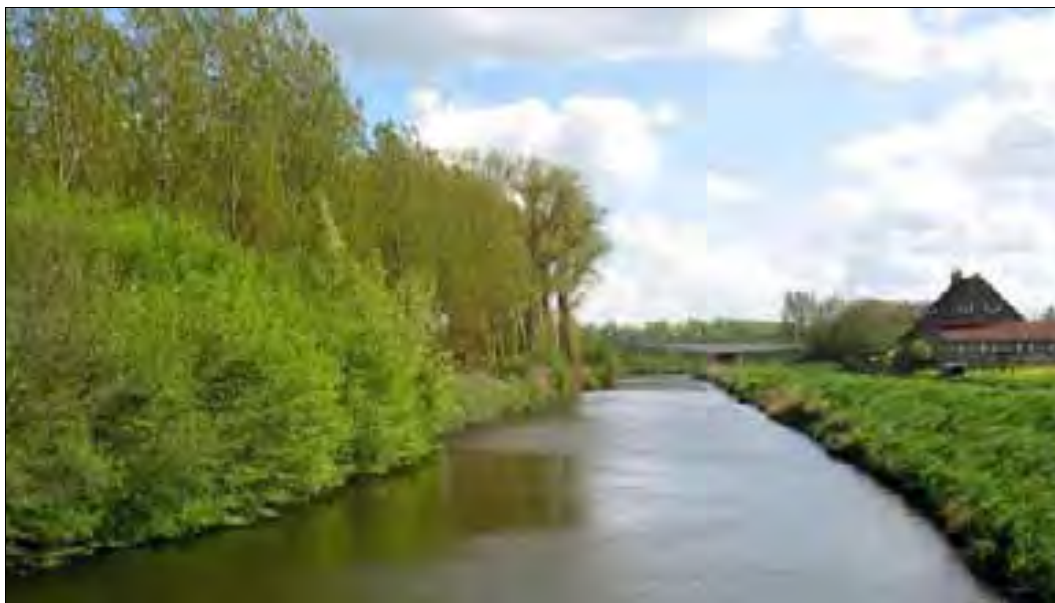
Foto 89. Een tak van het Afleidingskanaal van de Leie ter hoogte van de kruising met het kanaal Gent-Brugge heeft geen scheepvaartfunctie meer. Het verwijderen van (resten van) de vroegere oeververdediging en het creëren van flauwe taluds t.h.v. de waterlijn zal de oevervegetatie bevorderen. Bovendien zullen foerageer-, rust-, paai- en broedplaatsen ontstaan voor allerlei dieren. Aan de linkerzijde van de foto is een iepestruweel van “het eiland” te zien. Het struweel zal niet uitgroeien tot bomen door het optreden van de iepenziekte. Een continue verjonging van het struweel gebeurt door wortelopslag. Dergelijk struweel wordt best ongemoeid gelaten.
