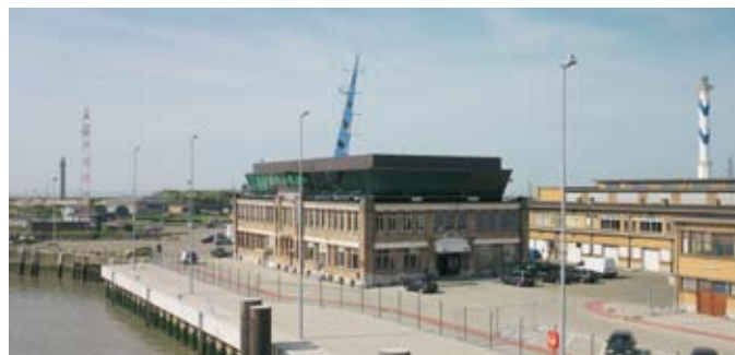
De nieuwe zetel van de afdeling Scheepvaartbegeleiding in Oostende
