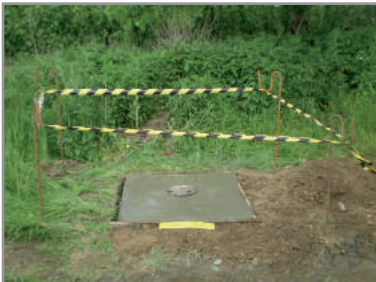
Figuur 12g: Herstelde peilput van het freatisch grondwatermeetnet.
