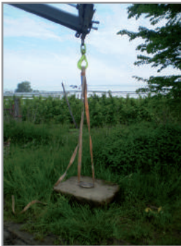
Figuur 12b: Verwijderen van de betonsokkel tijdens de herstelling van een put van het freatische grondwatermeetnet.
