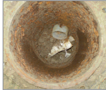
Figuur 12a: Kapotte put van het freatisch grondwatermeetnet.
