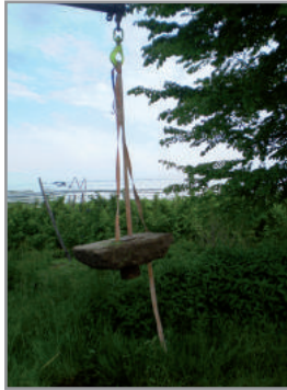
Figuur 12b: Verwijderen van de betonsokkel tijdens de herstelling van een put van het freatische grondwatermeetnet.
