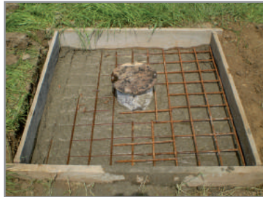
Figuur 12f: Er wordt een bekisting gemaakt om opnieuw te betonneren.
