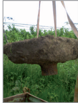
Figuur 12b: Verwijderen van de betonsokkel tijdens de herstelling van een put van het freatische grondwatermeetnet.
