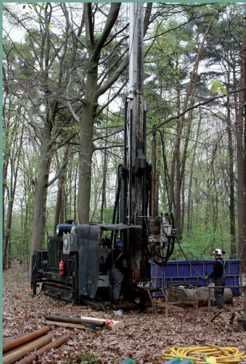
Figuur 4: Uitvoeren van een boring in ijzerzandsteen in het Gasthuisbos te Lubbeek.
