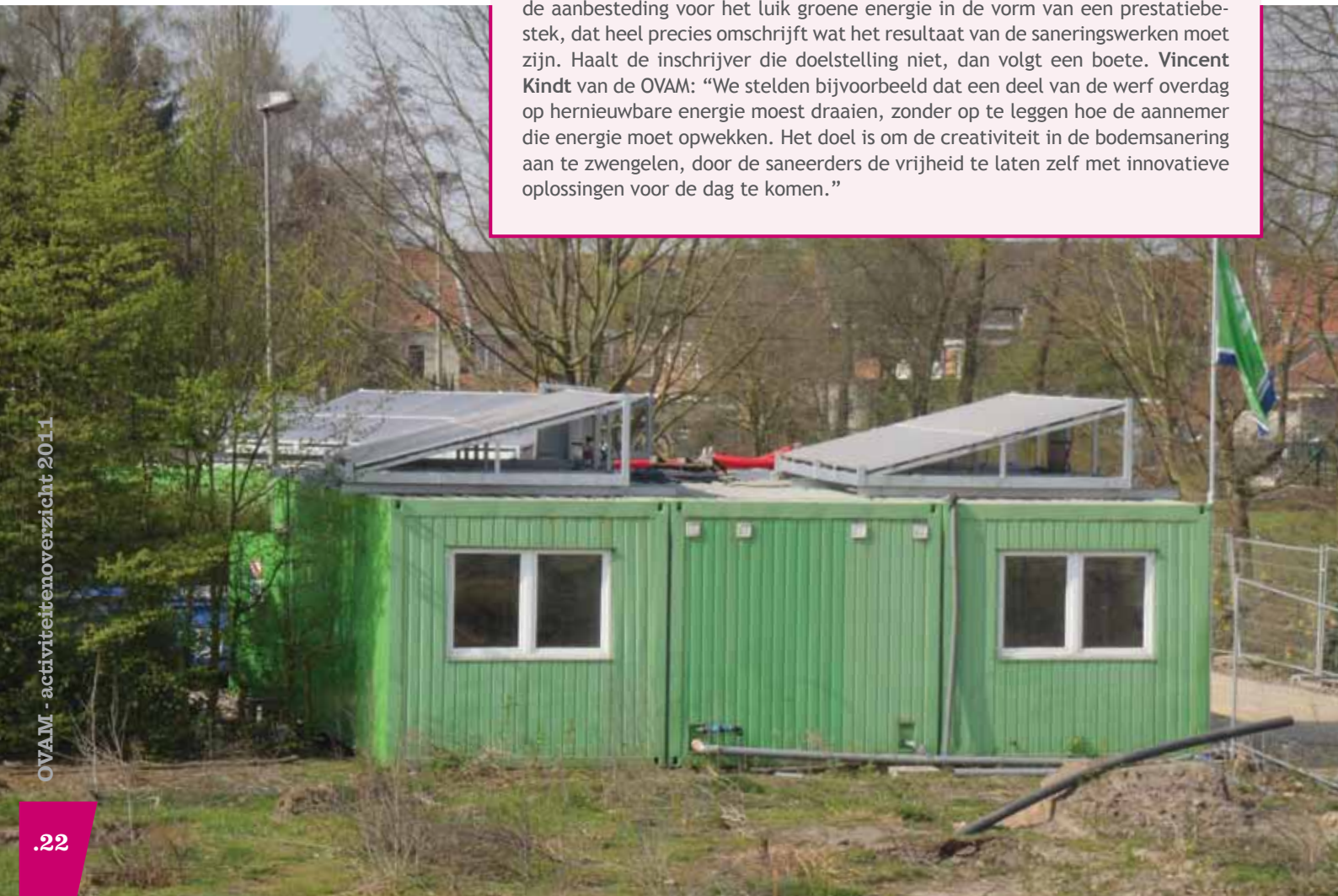
Zonnepanelen leveren energie op de Hoedhaarwerf in Lokeren
