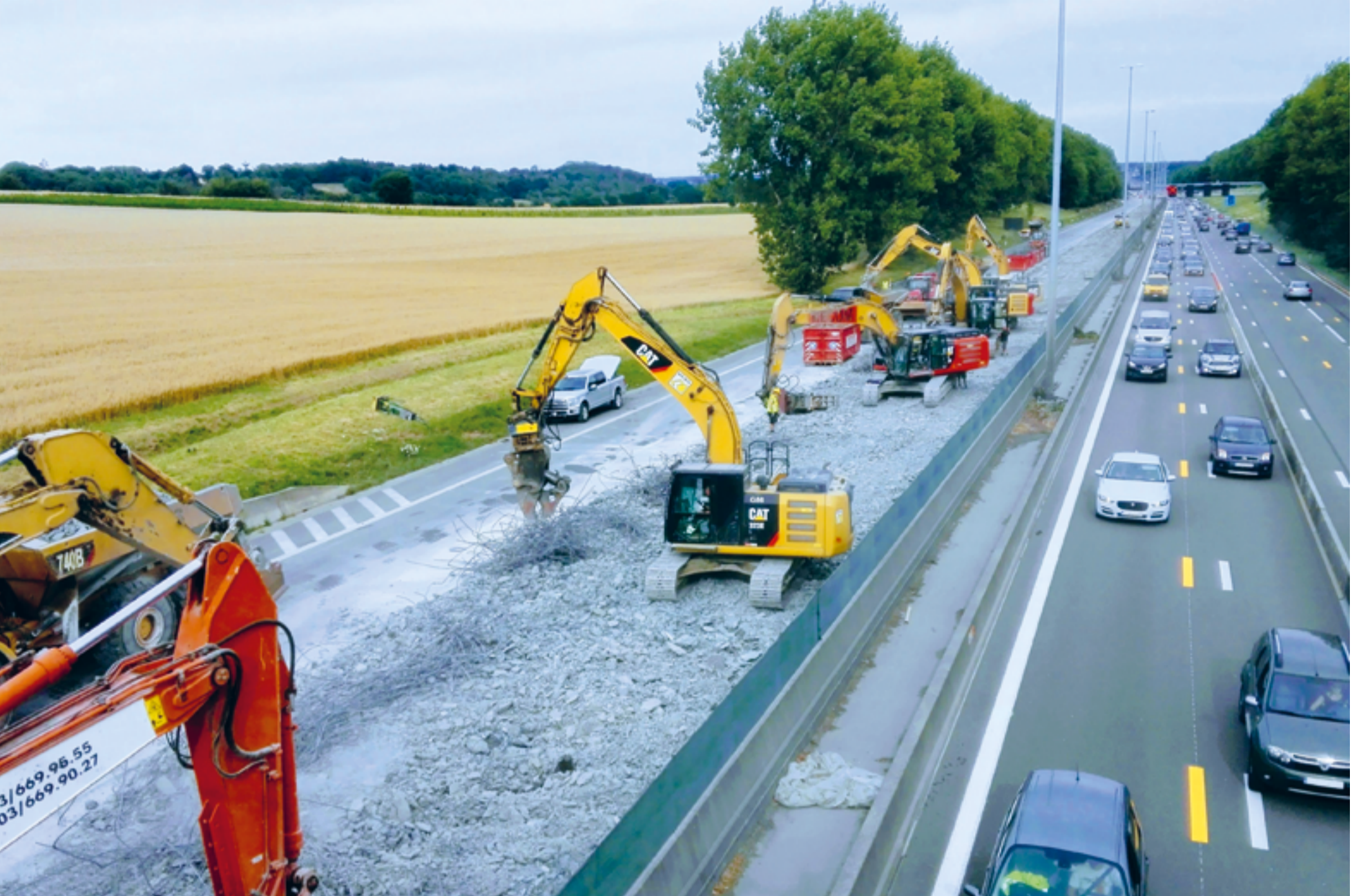
De klok rond werkten 180 arbeiders aan de E40.
