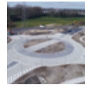
Aanleg rotonde t.h.v. ziekenhuis Alma Eeklo » p. 9
