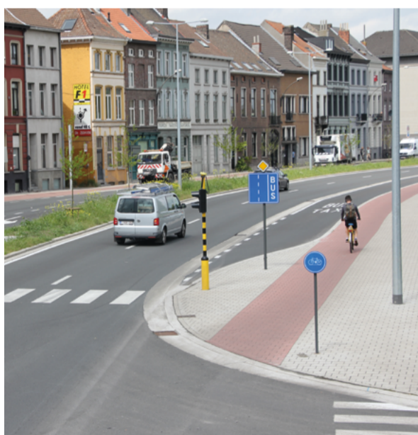
De vernieuwde verkeerssituatie.
