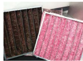
Glasvezel zakkenfilter: vervuild en nieuw.
