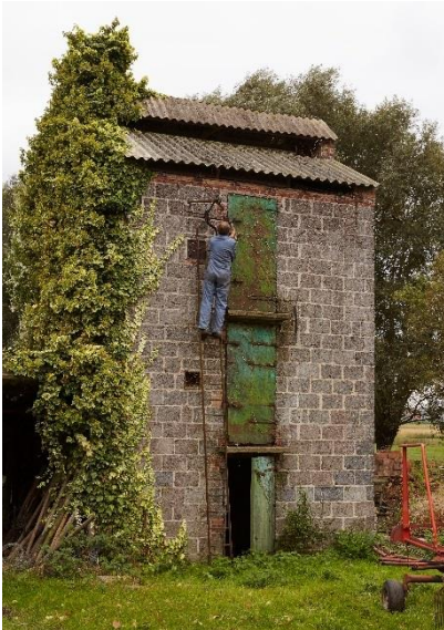
Fig. 43 - In assteen opgetrokken tabaksast in de Boomgaardstraat in Lichtegem (Collectie Onroerend Erfgoed, foto Kris Vandevorst).
