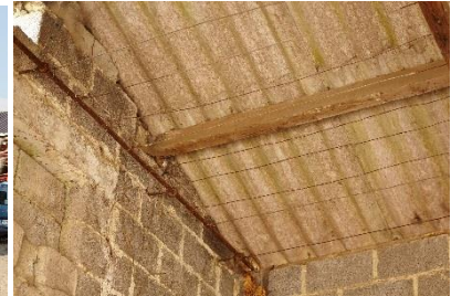
Fig. 43 - In assteen opgetrokken tabaksast in de Boomgaardstraat in Lichtegem (Collectie Onroerend Erfgoed, foto Kris Vandevorst).
