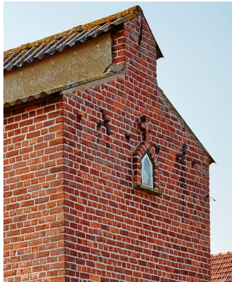
Fig. 71 - Tabaksast met klimijzers en laadplatform in de Amerikastraat in Wervik (Collectie Onroerend Erfgoed, foto Kris Vandevorst).
