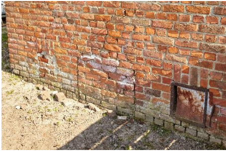
Fig. 42 - Verluchttingsgaten (of sporen ervan), links en rechts van het oven gat onderaan de tabaksast in de Hellestraat in Wervik (Collectie Onroerend Erfgoed, foto Kris Vandevorst).
