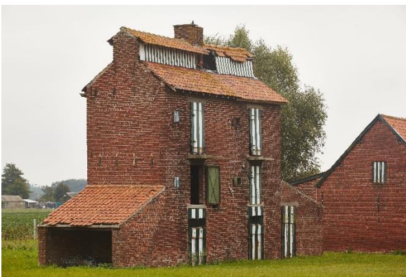
Fig. 49 - Tabaksast onder zadeldak met schouw en verhoogde nok in de Meulebekerstraat in Ingelmunster (Collectie Onroerend Erfgoed, foto Kris Vandevorst).
