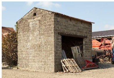
Fig. 43 - In assteen opgetrokken tabaksast in de Boomgaardstraat in Lichtegem (Collectie Onroerend Erfgoed, foto Kris Vandevorst).
