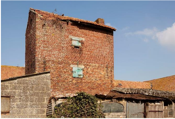
Fig. 57 - De (van ventilatieopeningen voorziene) achterzijde van de tabaksast op de hoeve in de Ravestraat in Moorslede (Collectie Onroerend Erfgoed, foto Kris Vandevorst).
