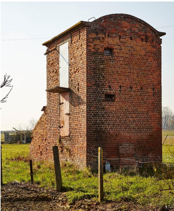
Fig. 69 - Kleine tabaksast met golvend betondak in de Kleiputstreet in Wervik (Collectie Onroerend Erfgoed, foto Kris Vandevorst).
