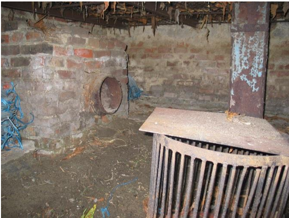
Fig. 32 - De metalen vuurkorf, gebruikt in de tabaksast in de Oude Beselarestreet in Wervik bij het buiten gebruik stellen van het buizensysteem (Collectie Nationaal Tabaksmuseum, Wervik).
