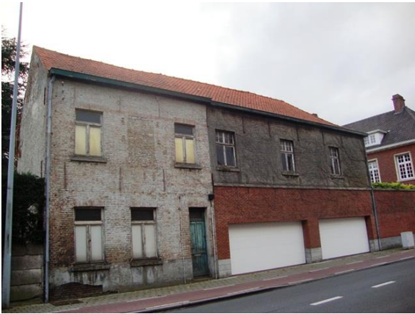
Fig. 197 - Het afgewolfd zadeldak van de tabaksfabriek Vermeulen in Ingelmunster (Collectie Onroerend Erfgoed, foto Kris Vandevorst).
