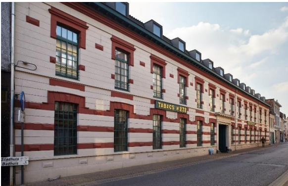
Fig. 217 - De voorgevel van de tabaksfabriek D'Heygere in de Ieperstraat in Menen (Collectie Collectie Onroerend Erfgoed, foto Kris Vandevorst).
