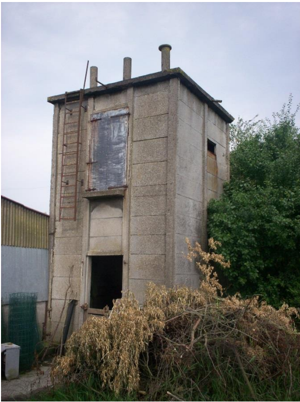
Fig. 46 - In betonplaten opgetrokken tabaksast in de Dadizelehoekstraat in Moorslede (Collectie Nationaal Tabaksmuseum, Wervik).
