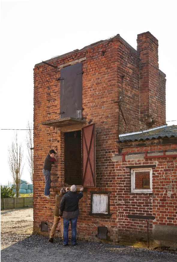
Fig. 34 - De tot cokesast aangepaste Lannoy-tabaksast in de Amerikastraat in Wervik (Collectie Onroerend Erfgoed, foto Kris Vandevorst).
