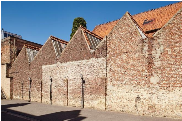
Fig. 204 - De van een zaagtanddak voorziene vleugel van de tabaksfabriek Van der Cruyssen in Deinze (Collectie Onroerend Erfgoed, foto Kris Vandevorst).
