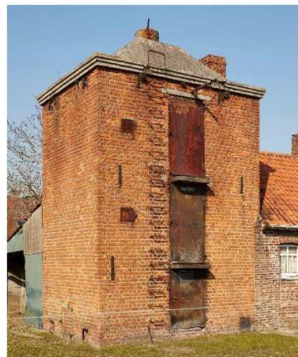
Fig. 65 - Achterzijde van de tabaksast onder betonnen tentdak in de Bosstraat in Ardoois (Collectie Onroerend Erfgoed, foto Kris Vandevorst).
