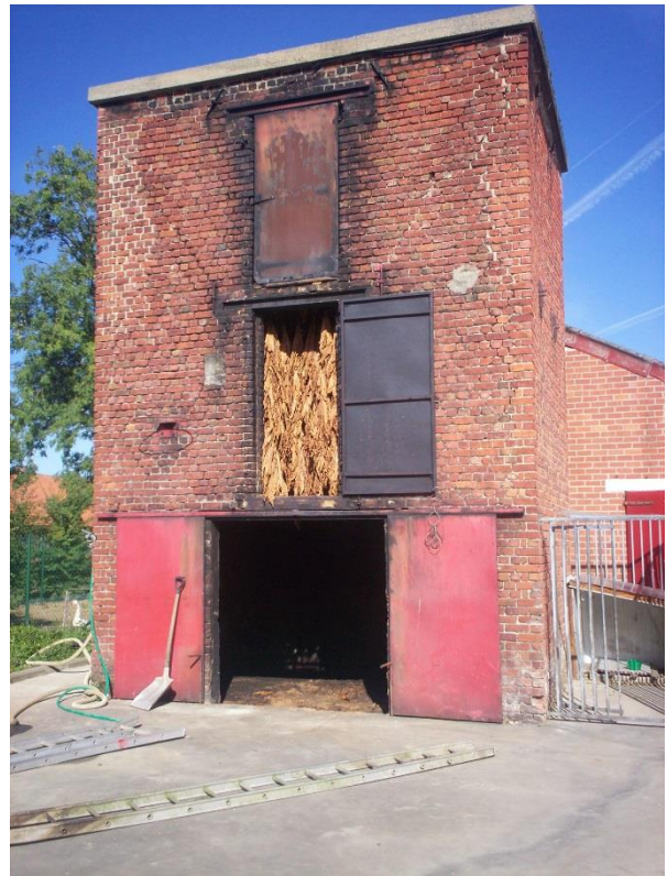
Fig. 36 - Droogvloer of -kader met op 15 cm van elkaar gespannen ijzerdraden in de tabaksast op de hoeve Dhondt in Menen (Collectie Onroerend Erfgoed, foto Kris Vandevorst).
