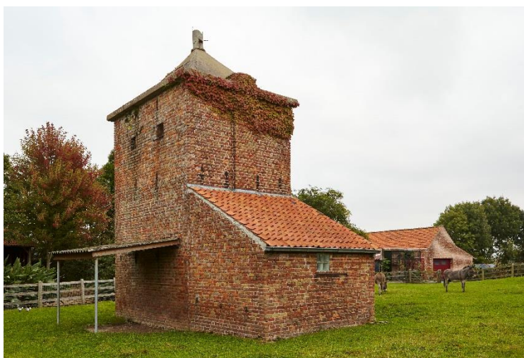
Fig. 65 - Achterzijde van de tabaksast onder betonnen tentdak in de Bosstraat in Ardoois (Collectie Onroerend Erfgoed, foto Kris Vandevorst).
