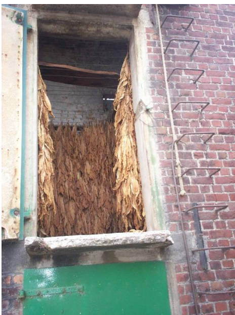
Fig. 27 - De klimijzers van de tabaksast in de Tuimelarestreet in Moorslede (Collectie Nationaal Tabaksmuseum, Wervik).
