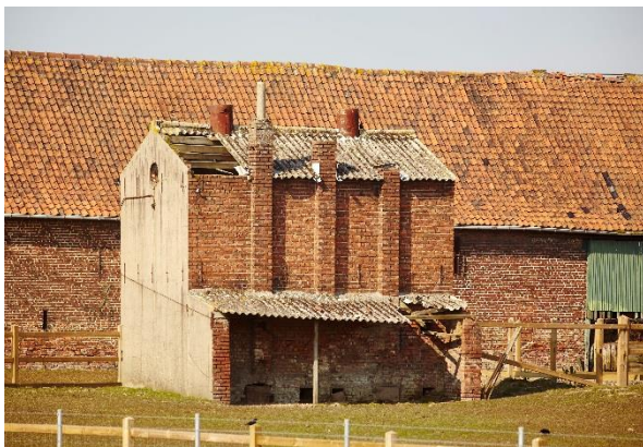
Fig. 55 - De tabaksast op de hoeve Ter Walle in Wervik met zijn twee verluchtingsschouwen, drie schoorstenen en afdak (Collectie Onroerend Erfgoed, foto Kris Vandevorst).
