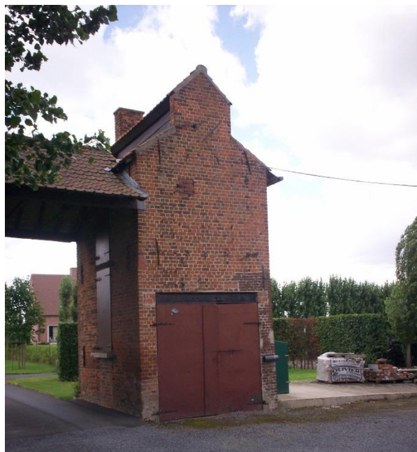
Fig. 49 - Tabaksast onder zadeldak met schouw en verhoogde nok in de Meulebekerstraat in Ingelmunster (Collectie Onroerend Erfgoed, foto Kris Vandevorst).
