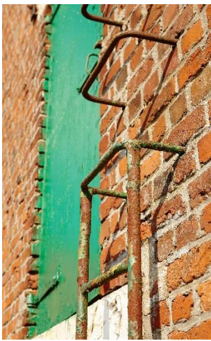
Fig. 59 - Detail van de klimijzers van de tabaksast op het erf van de hoeve Segaert in de Heulestraat in Moorslede (Collectie Onroerend Erfgoed, foto Kris Vandevorst).
