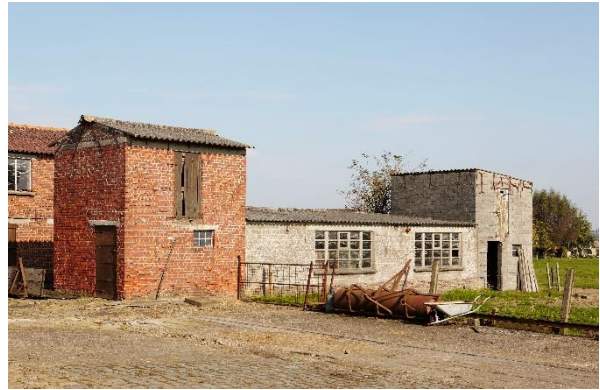
Fig. 46 - In betonplaten opgetrokken tabaksast in de Dadizelehoekstraat in Moorslede (Collectie Nationaal Tabaksmuseum, Wervik).
