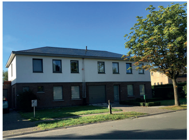
Nevele Volkshaard na renovatie
