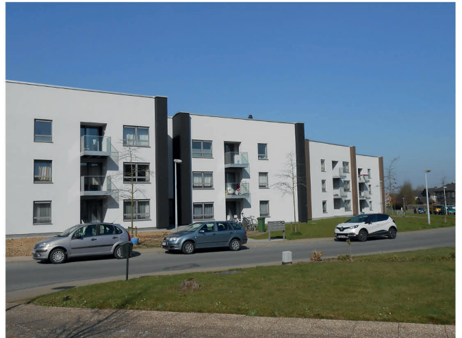
Denderleeuw Dewaco na renovatie
