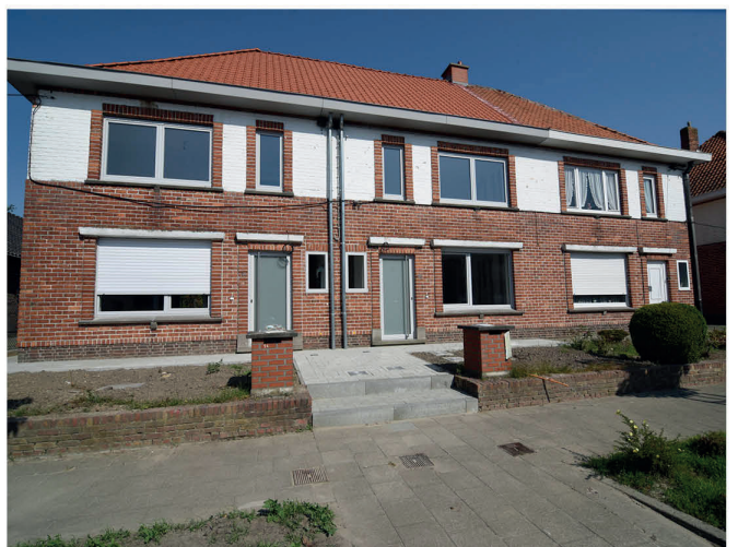
Hamme De Zonnige Woonst na renovatie
