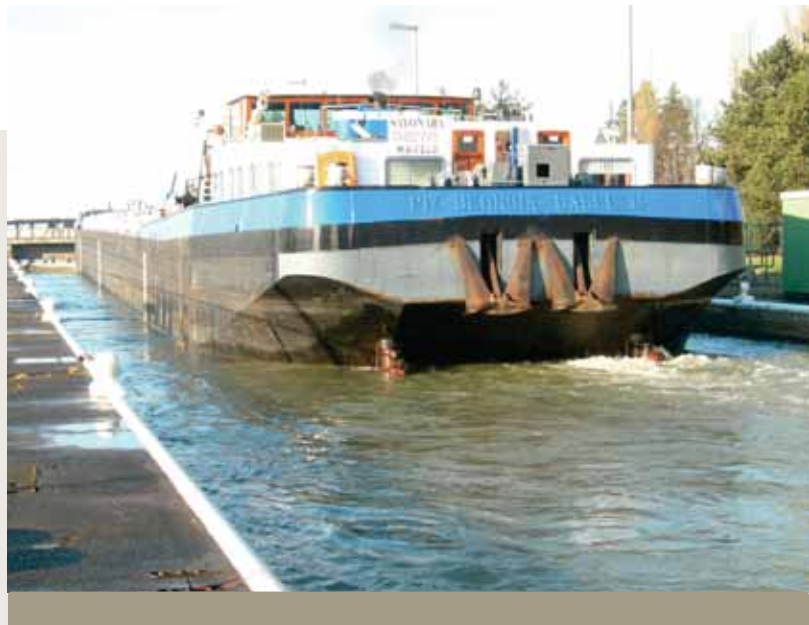
658_2 Albertkanaal – 16m sluisen – Vervanging wagenschuiven door vlinderkleppen – Optimalisering lediging middensas Genk
