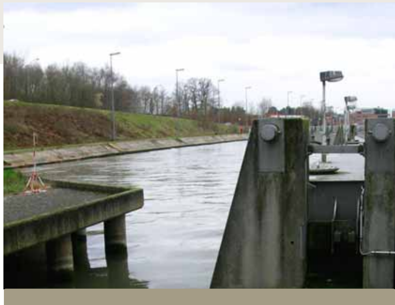
841_01 Albertkanaal - Pompinstallaties en waterkrachtcentrales
