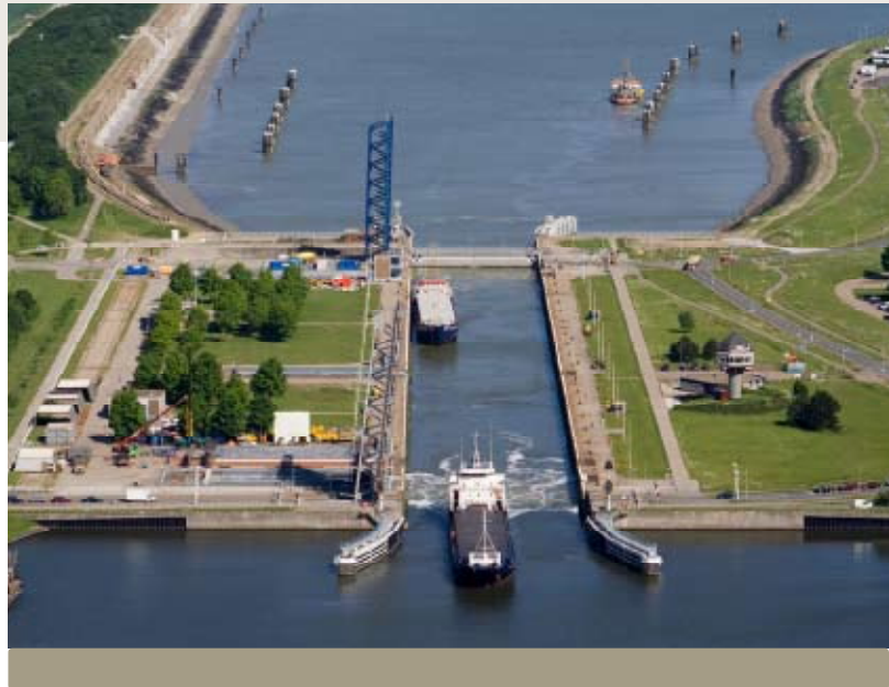
Bron Rijkswaterstaat Nederland – Een overzichtsfoto van de nieuwe en oude basculebruggen te Terneuzen
