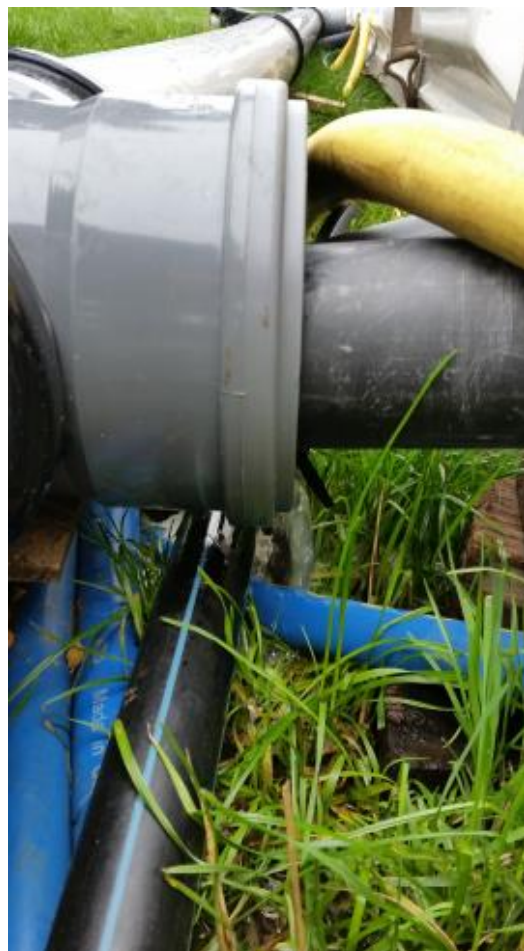
Beeld van de afvoer van enkele douche-units, met een kleine zichtbare lekkage (detail rechts).
