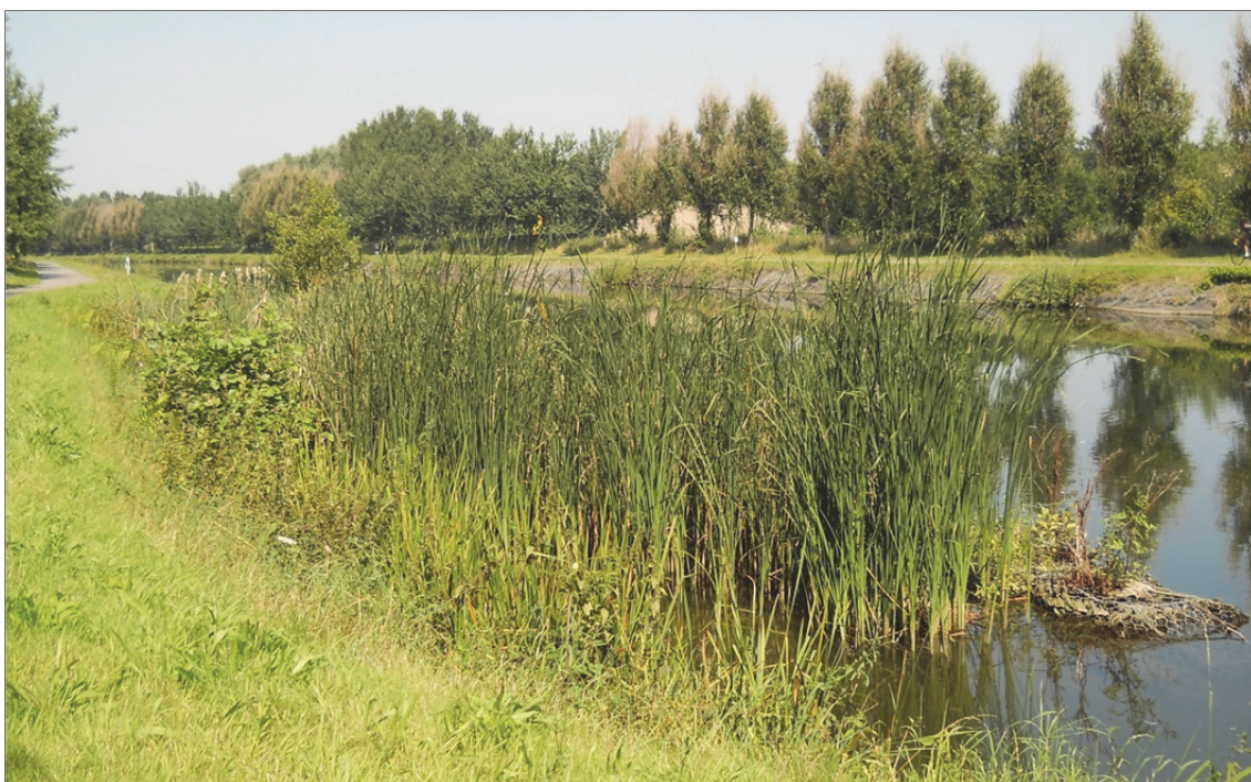
Foto 5. Plasberm langs het Kanaal Leuven-Dijle te Boortmeerbeek stroomafwaarts de Bieststraat.
