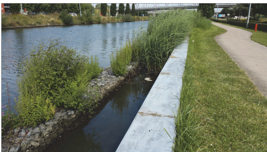
Foto 19. Overzichtsfoto van de plasberm te Leuven in 2012 (boven) en 2016 (onder).
