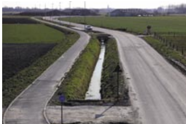
➤ Met het oog op de afwatering van de weg is de gracht behouden tussen de weg en het fietspad.
