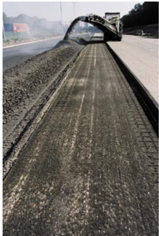
➤ Van de bestaande asfaltverharding wordt 15 à 20 cm afgefreesd.
