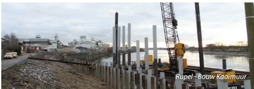
Albertkanaal - Terminal Meerhout
