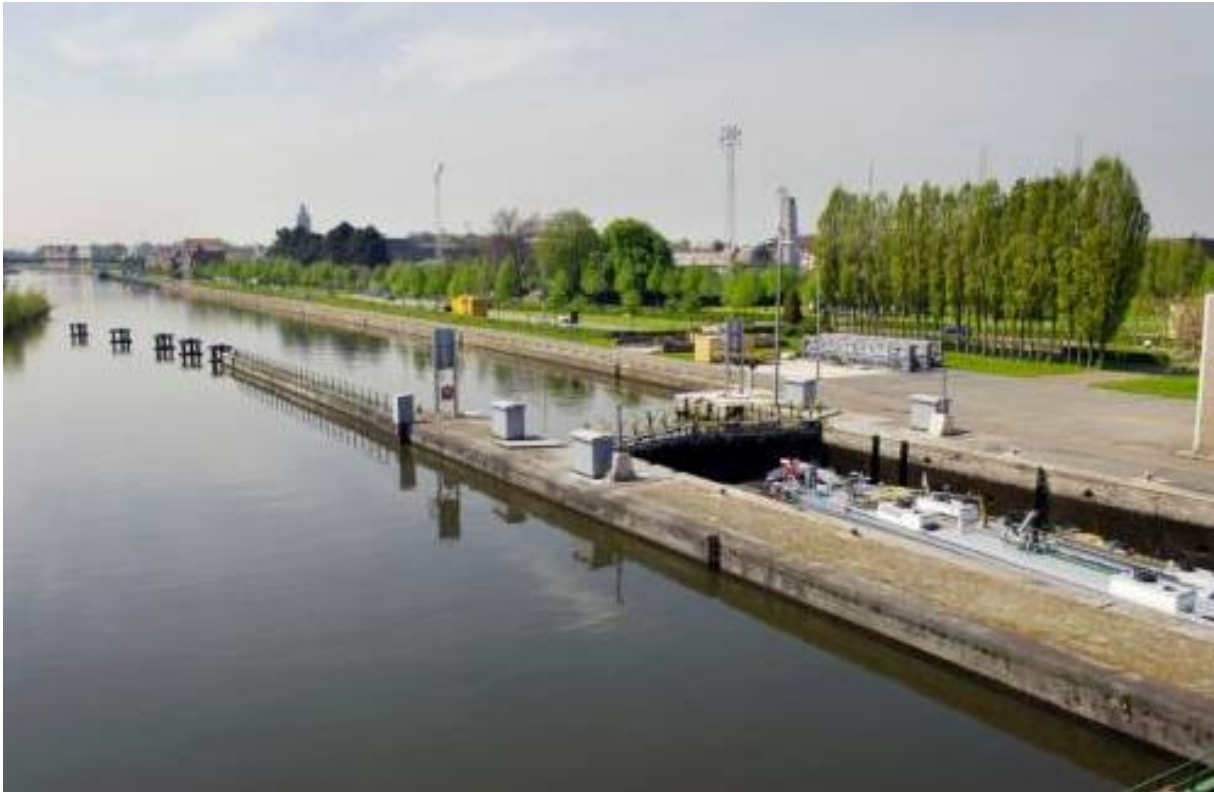
Figuur: sluizen op de Boven-Schelde
