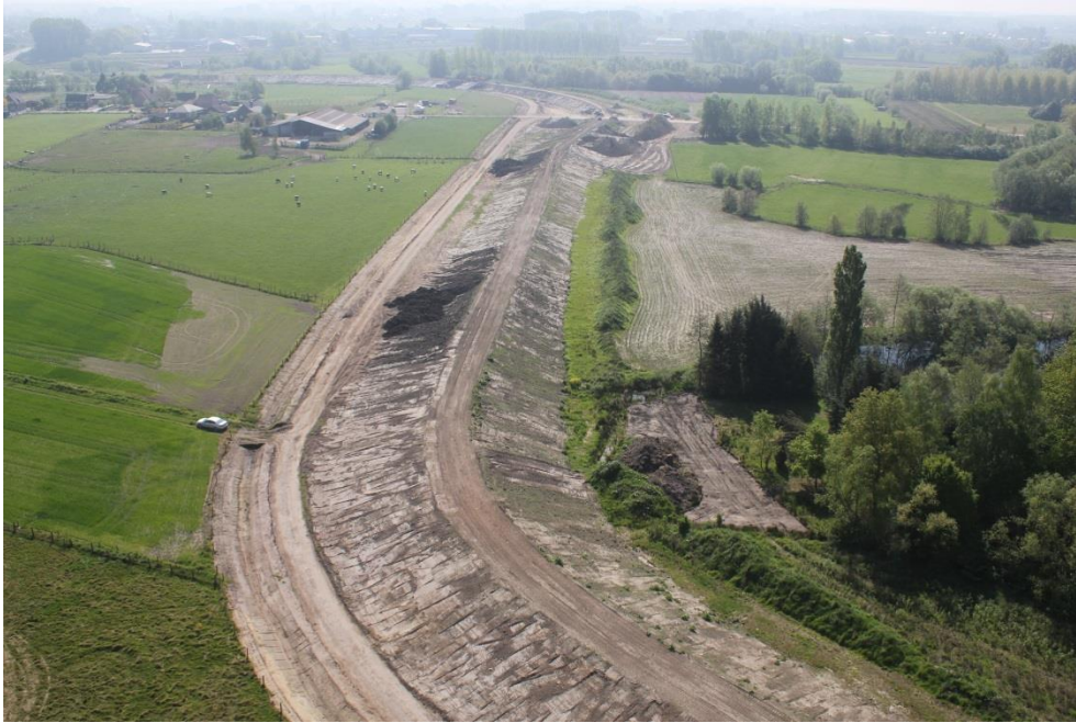
Figuur 3: aanleg van de ringdijk in Wijmeers
