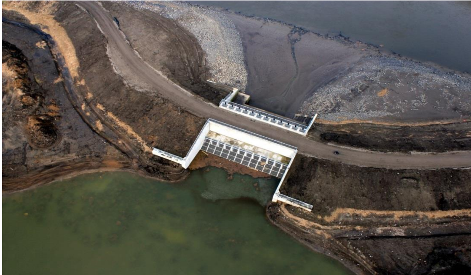
Figuur 2c: in- en uitwateringssluis in het GGG Bergenmeersen
