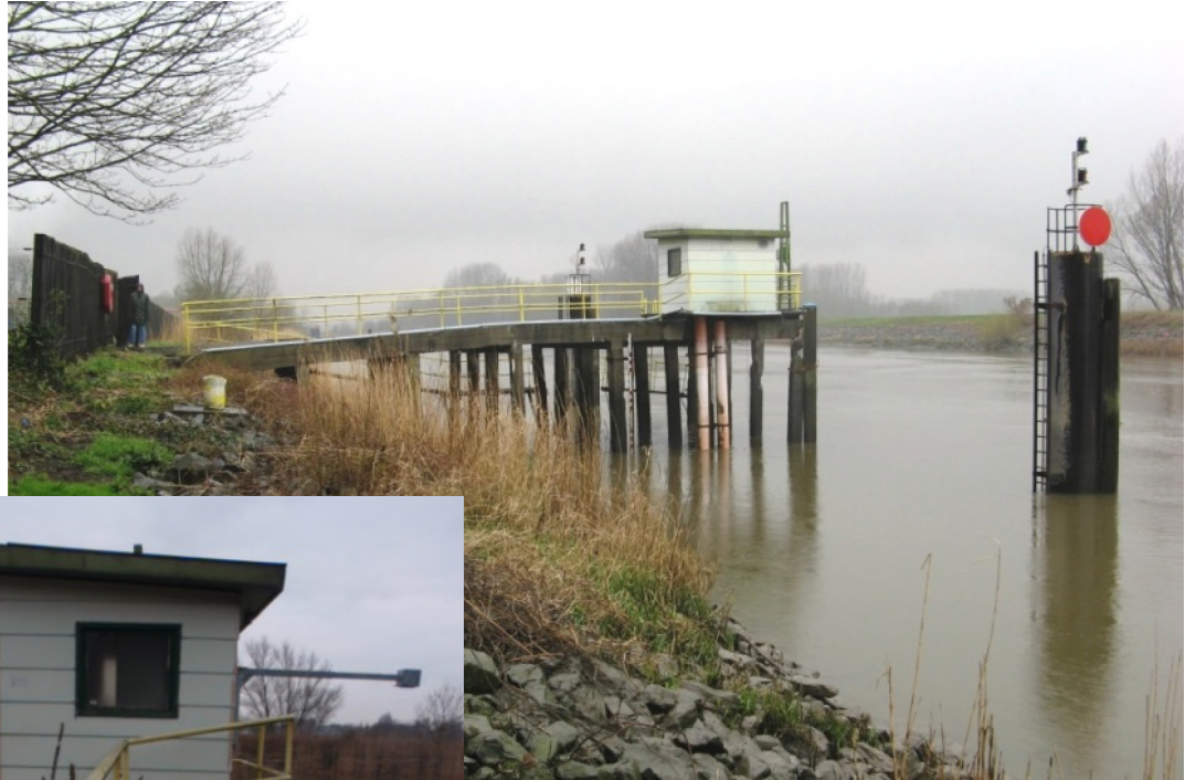
Figuur 18 - Tijmeetinstallatie te Schoonaarde op de Boven Zeeschelde.
