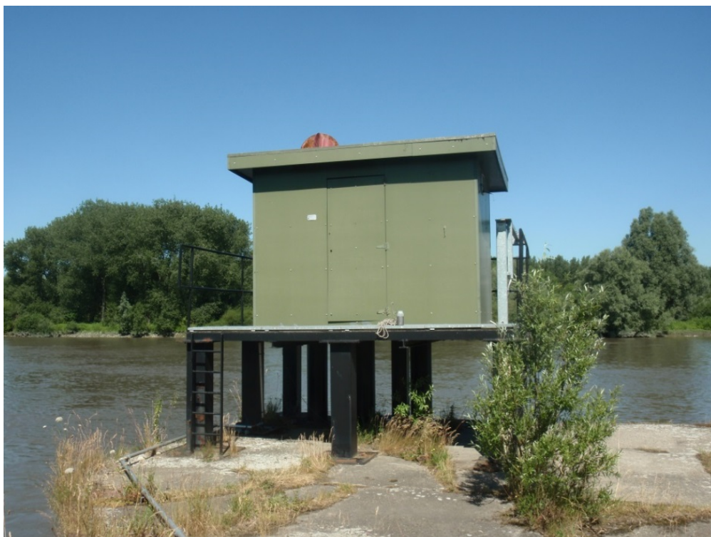
Figuur 16 - Tijmeetinstallatie te Sint-Amands op de Boven Zeeschelde.
