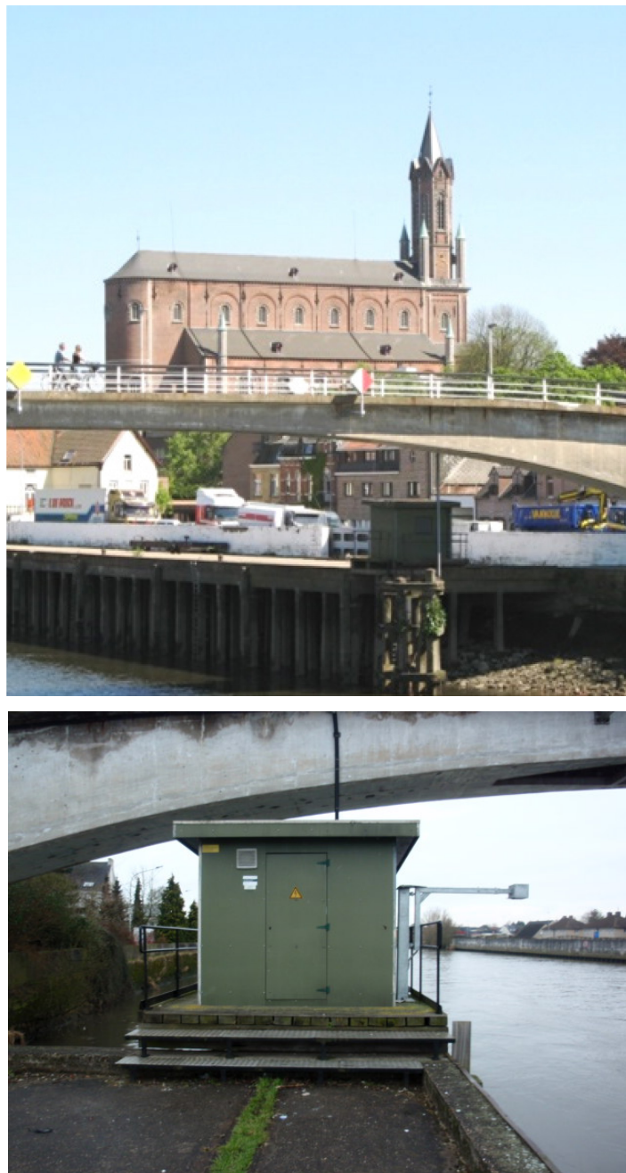
Figuur 20 - Tijmeetinstallatie te Wetteren op de Boven Zeeschelde.
