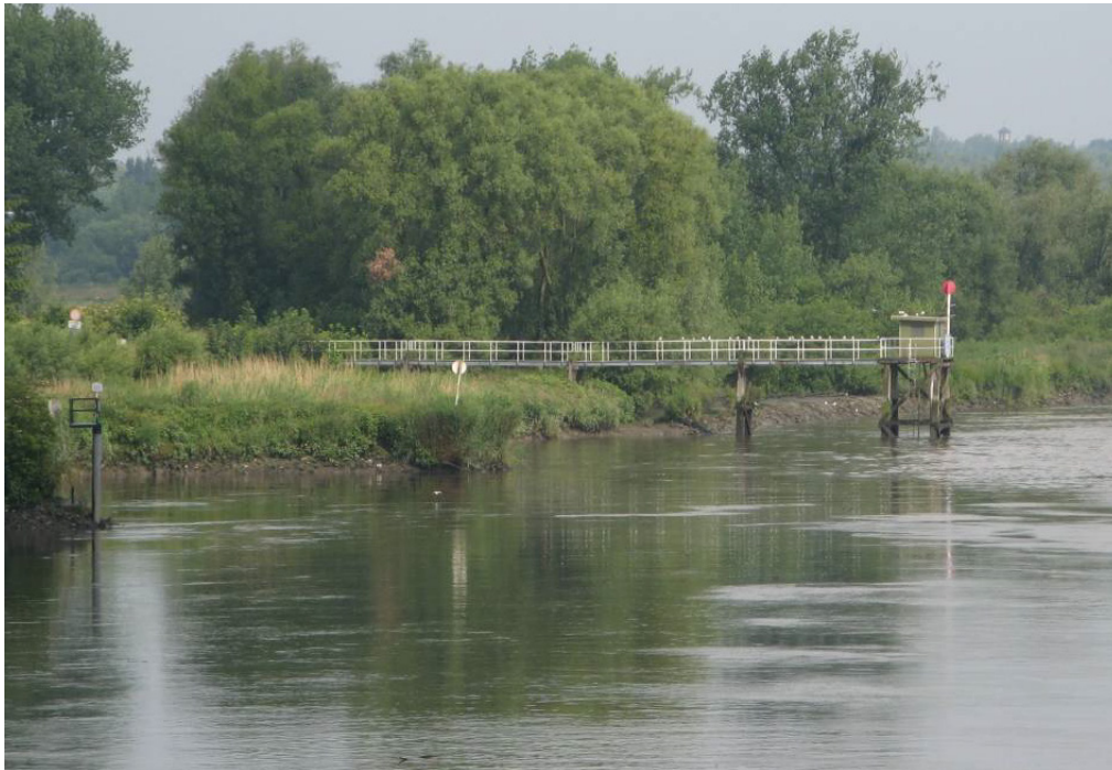
Figuur 23 - Tijmeetinstallatie te Walem op de Rupel
