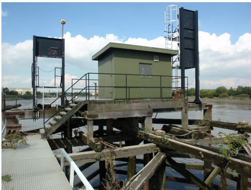
Figuur 22 - Tijmeetinstallatie te Boom op de Rupel.
