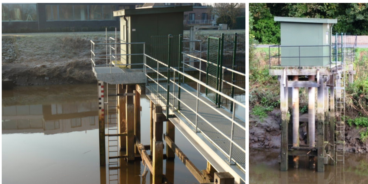
Figuur 25 - Tijmeetinstallatie te Lier Molbrug op de Beneden Nete
