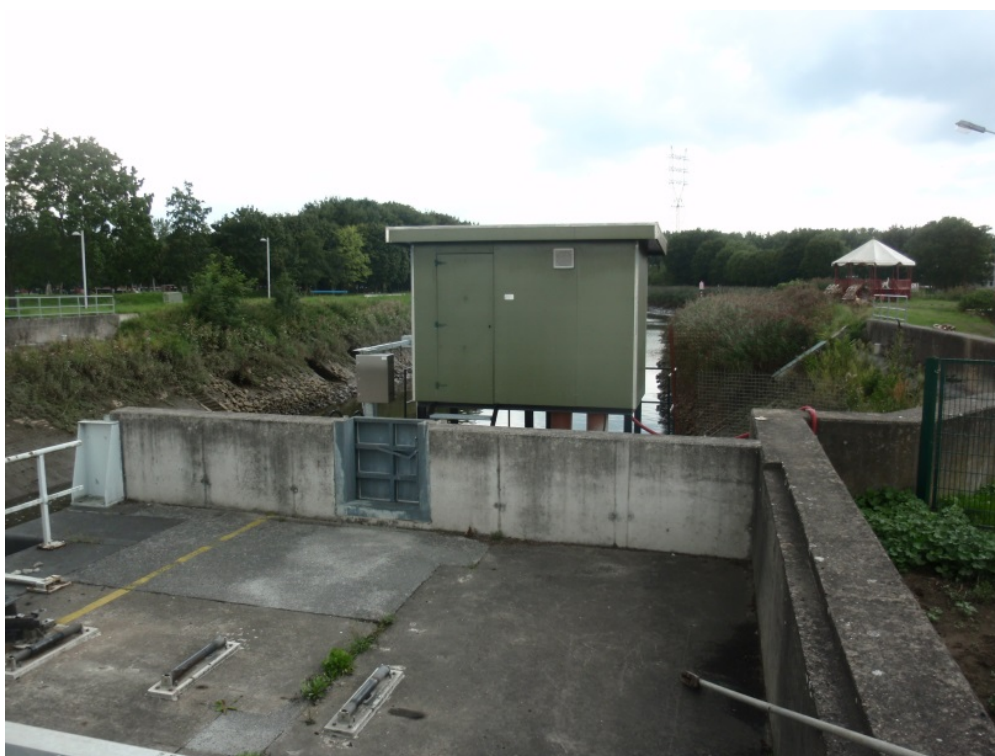
Figuur 29 - Tijmeetinstallatie te Mechelen Benedensluis op de Dijle
