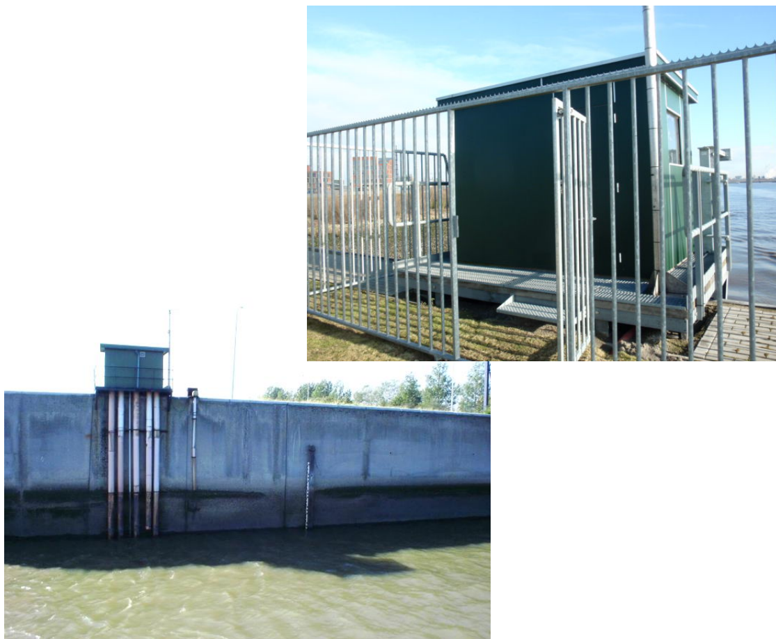
Figuur 9 - Tijmeetinstallatie te Kallosluis op de Beneden-Zeeschelde
