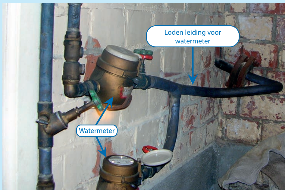
figuur 3: Loden leiding voor watermeter
