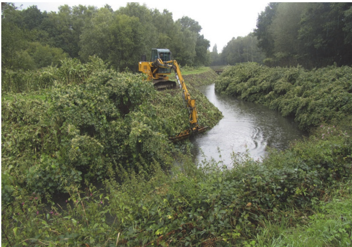
Figuur 16 Ruiming van een waterloop met invasieve duizendknoop tijdens het vegetatie seizoen. Het geruimde materiaal wordt op de oever worden gedeponeerd - © Sus Willems, ANB.
