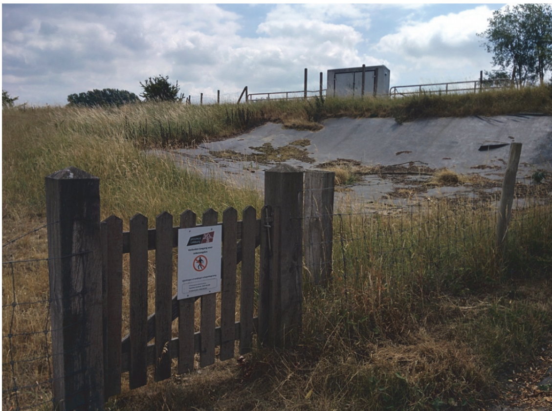
Figuur 36 Naast een bufferbekken op de Kleine Herk te Wellen werd een haard invasieve duizendknoop gedurende 7 jaar afgedekt met een ingegraven water- en luchtdichte folie.
