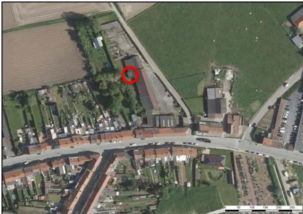
Fig. 3 Luchtfoto, genomen vóór de afbraak van de loods en de verwijdering van de opslagtanks voor brandstof.
