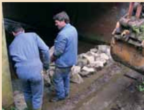
Foto 2.2: a & b: Bouw van een V-vormige overlaat uit beton en handmatig ingebedde stortstenen op de bodemplaat in de hoofdloop van de Grote Nete en onder de brug van de Molenstraat te Meerhout.
