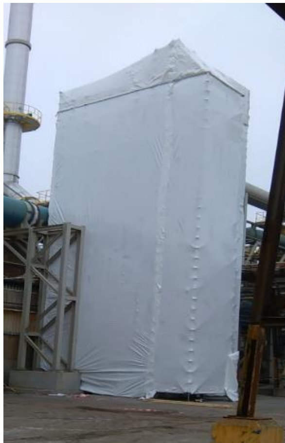
Figuur 40: Preventief inpakken van silo in afwachting van herstellingswerken van de stofsilo
