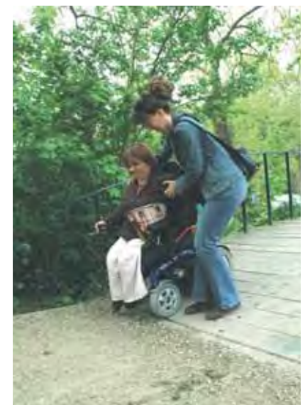
Ronde brug: de helling is te groot waardoor de rolstoelgebruiker uit de rolstoel kan vallen.
