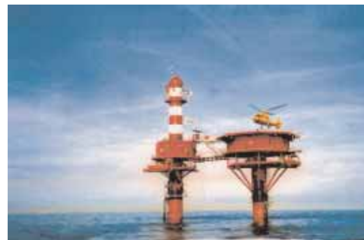
Radartoren Oostdyckbank, Oostende
