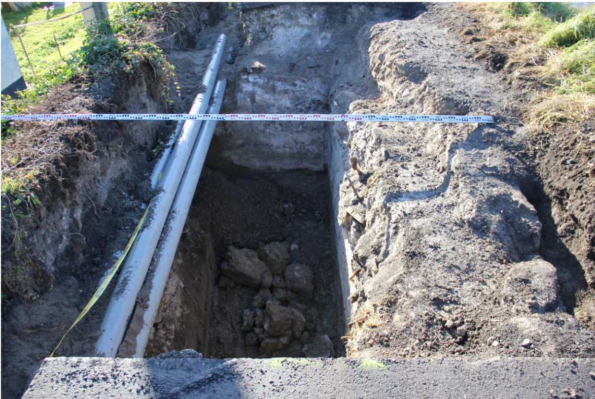
Fig. 8: Het verdere onderzoek op 11 oktober. Algemeen zicht vanuit het noorden op de vrijgelegde bunker. De muurdikte en het niveau van de wapening (halfweg de dakbedekking) zijn duidelijk.
