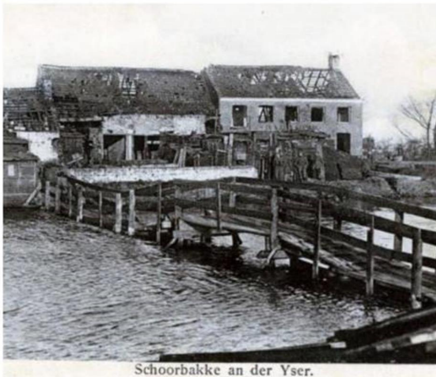
Fig. 21: Op deze foto met zicht op de tijdelijke voetgangersbrug ter hoogte van Schoorbakke, genomen vanop de overkant, is op de dijk (rechteroever oost) een met zandzakken ingekapselde schuilplaats te zien. Dit is mogelijk de voorganger van de geregistreerde bunker. Sowieso kan het als mogelijk voorbeeld dienen voor het uitzicht van de oudere structuur. Uit: collectie RVT ( https://www.routeyou.com/nl-be/location/view/47922509/infobord-schoorbakke-woi ).
