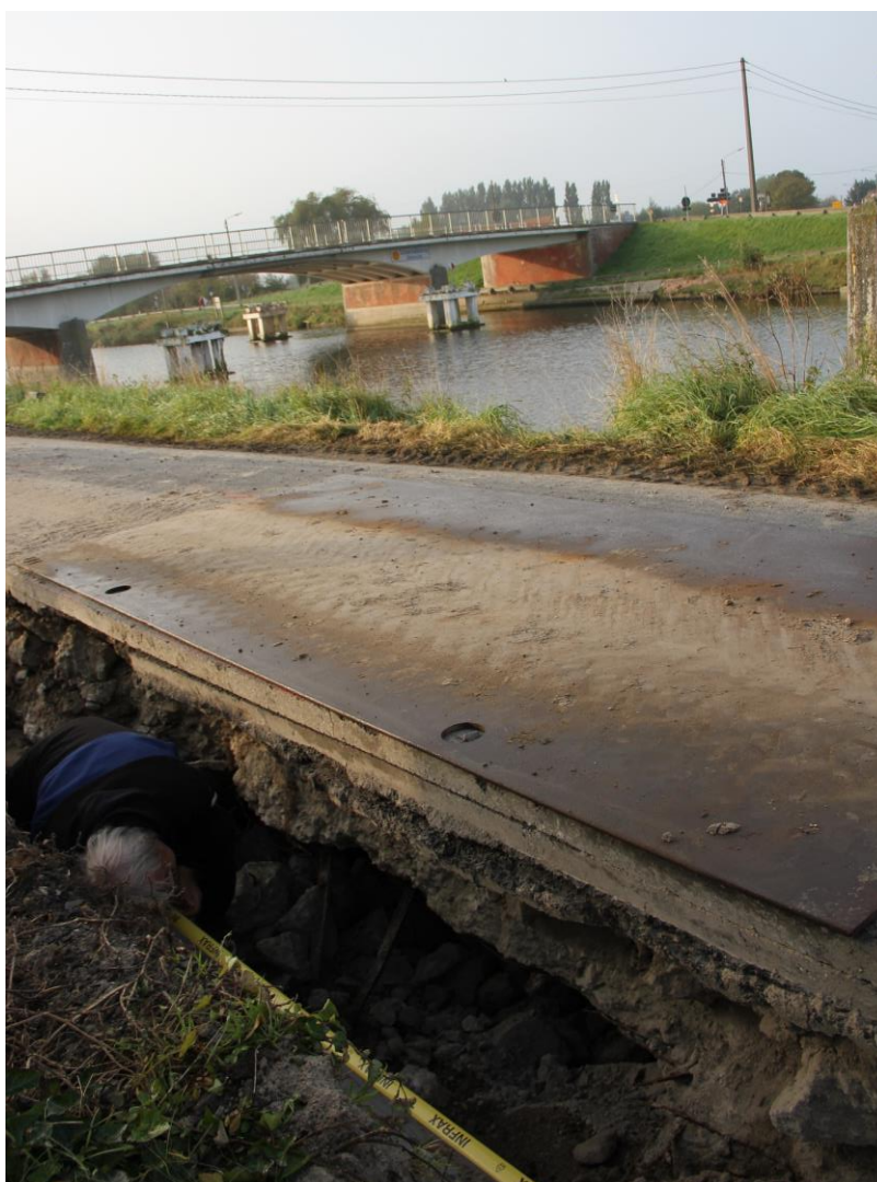
Fig. 1: Algemeen zicht op de vindplaats tijdens de terreinevaluatie op donderdag 4 oktober. Evaluatie van de aangesneden bunker die verder doorloopt onder het wegdek. Zicht naar het zuiden met op de achtergrond de Schoorbakkebrug.
