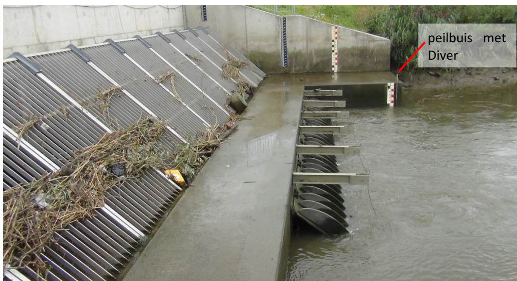
Figuur 13 – Locatie WL-waterpeilmeting aan rivierzijde gecombineerde in- en uitwateringconstructie Bergenmeersen
