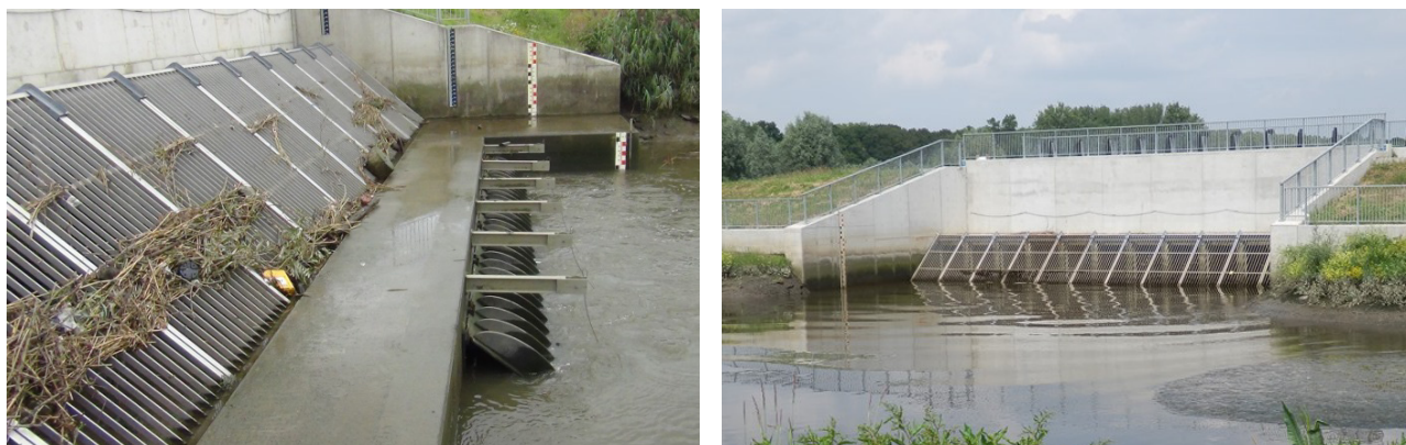
Figuur 2 – Foto's gecombineerde in- en uitwateringsconstructie Bergenmeersen
