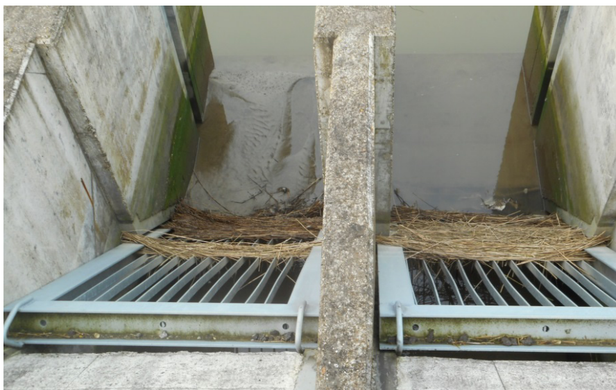
Figuur 32 – Illustratie verstopping vuilroosters Bazel tijdens plaats bezoek op 17/10/2017
