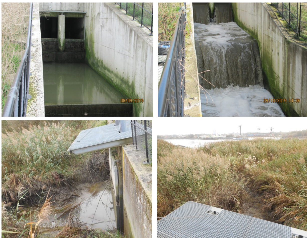
Figuur 6 – Foto's Noordelijke inwateringsconstructie GOG-GGG Bazel
