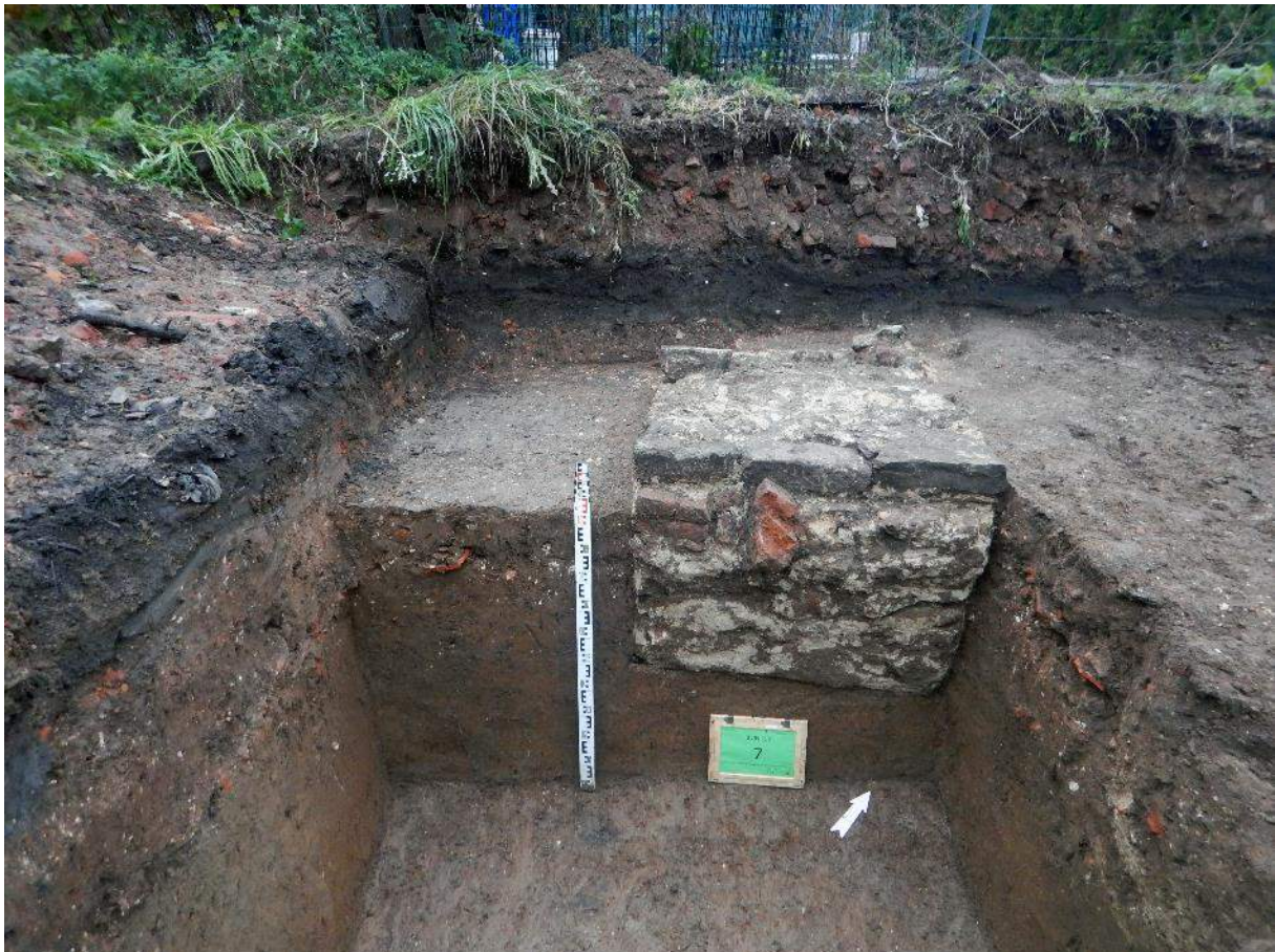
Figuur 108 Steunbeer S1 na verder opgraven met metselwerk in kalkzandsteen doorspekt met baksteenfragmenten
