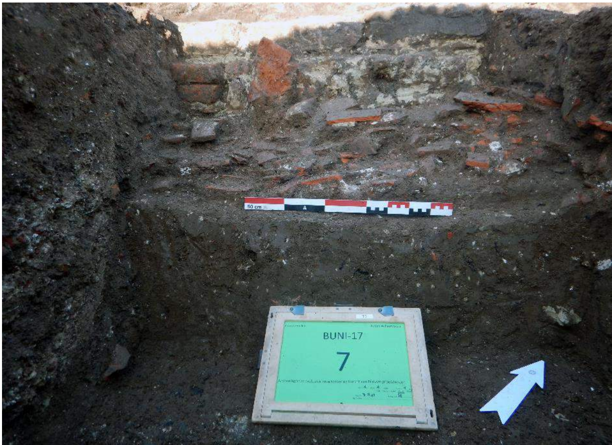
Figuur 107 Steunbeer S1 na lokale verdieping van het vlak: bovenaan het parament in veldsteen en op funderingshoogte een aantal laagjes horizontaal liggende daktegelfragmenten.
