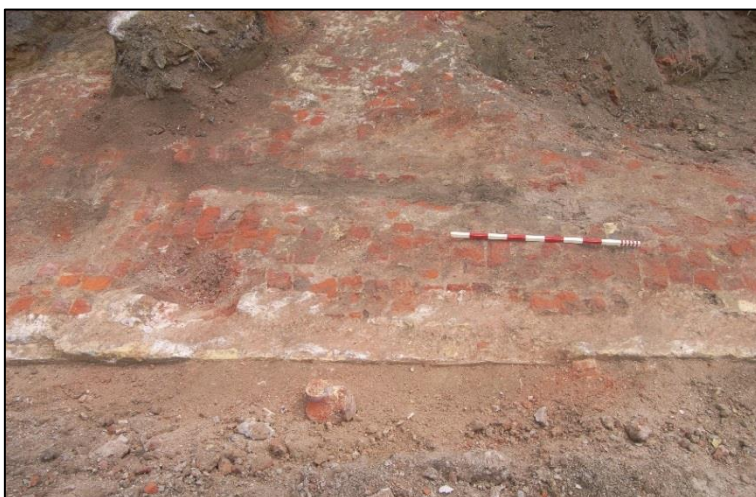
Fig. 6 Het nieuwe parement haakt zich via vertandingen vast in het oudere muurvolumen.
