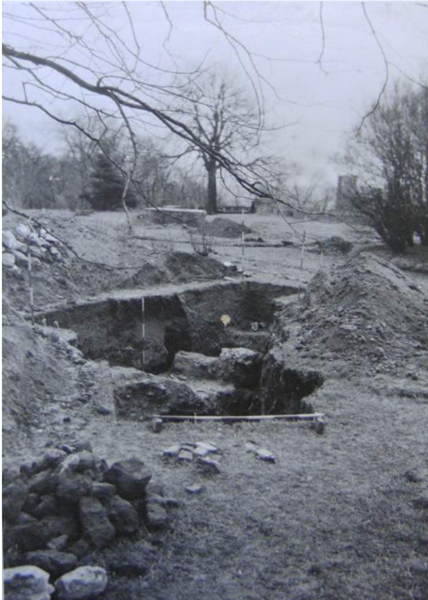
Figuur 35. Foto van een zoeksleuf aangelegd door Van Humbeeck op de burchtzone, meer bepaald tussen de noordelijke toren van de toegangspoort en de muurtoren in de noordelijke ringmuur. (bron: archief abdij Keizersberg)
