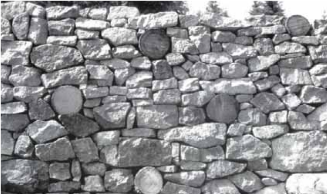
Figuur 13. Voorbeeld van het vooraanzicht van een murus Gallicus zoals gereconstrueerd te Bibracte in Frankrijk (bron: Fichtl, 2005: 50).
