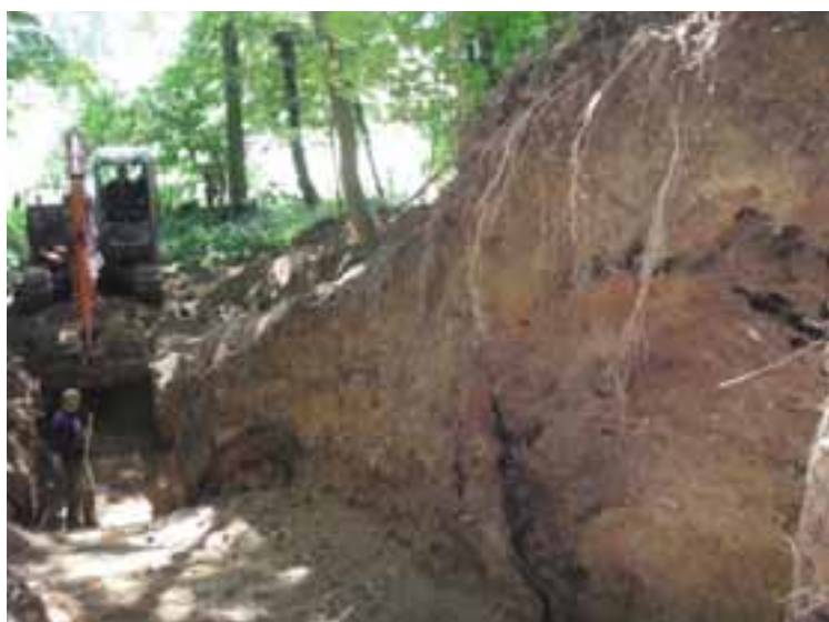
Figuur 62. Het uitgraven van sleuf 1974-6.
