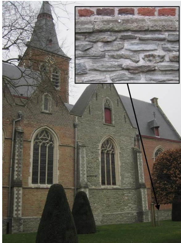
Figuur 119 - Bij het bouwen van de Sint-Corneliuskerk te Aalter werden lokale veldstenen gebruikt.
