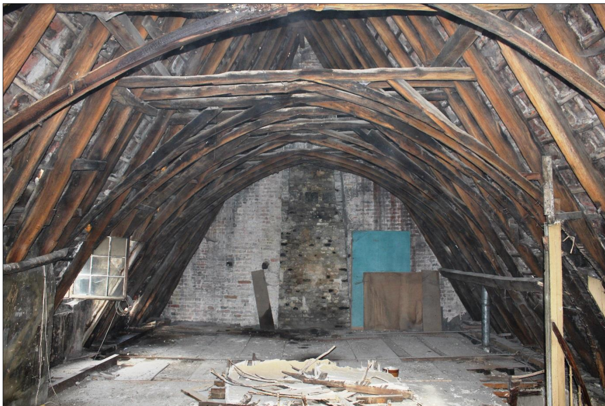
Fig. 16: de dakkap gezien naar het noorden (toestand 16 november 2016). Copyright Onroerend Erfgoed, foto: Vincent Debonne.
