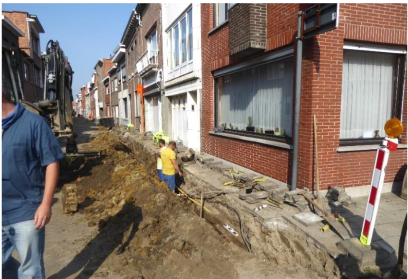
Figuur 51: Situering van de tweede aangetroffen muurfundering (© agentschap Onroerend Erfgoed).
