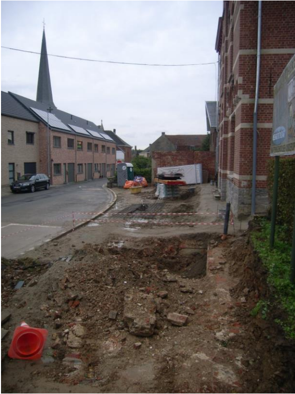
Figuur 13: Zicht op de werken ter hoogte van de oude pastorie (© agentschap Onroerend Erfgoed).
