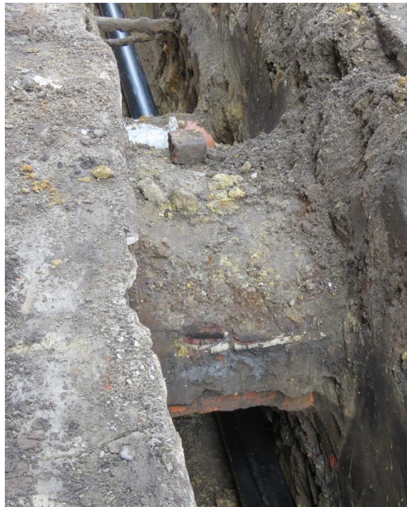
Figuur 77: De manier waarop de kabels en leidingen onder de muurstructuur ter hoogte van Advokaatstraat 30/32 werden getrokken.
