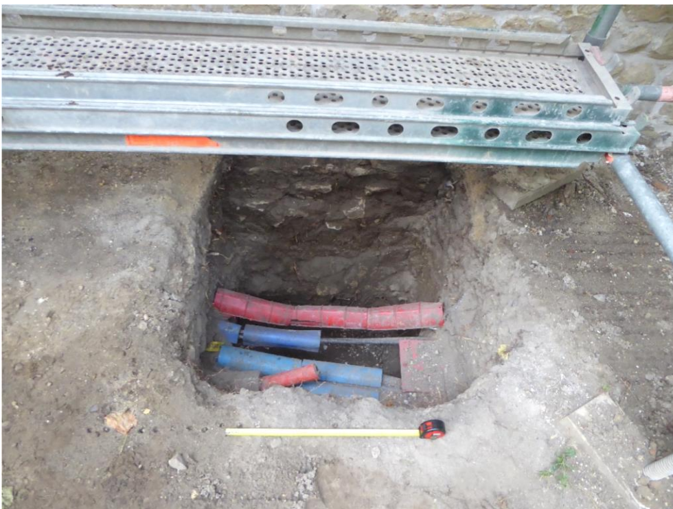
Figuur 147: De nutsleidingen waaronder de skeletresten werden aangetroffen (© agentschap Onroerend Erfgoed).
