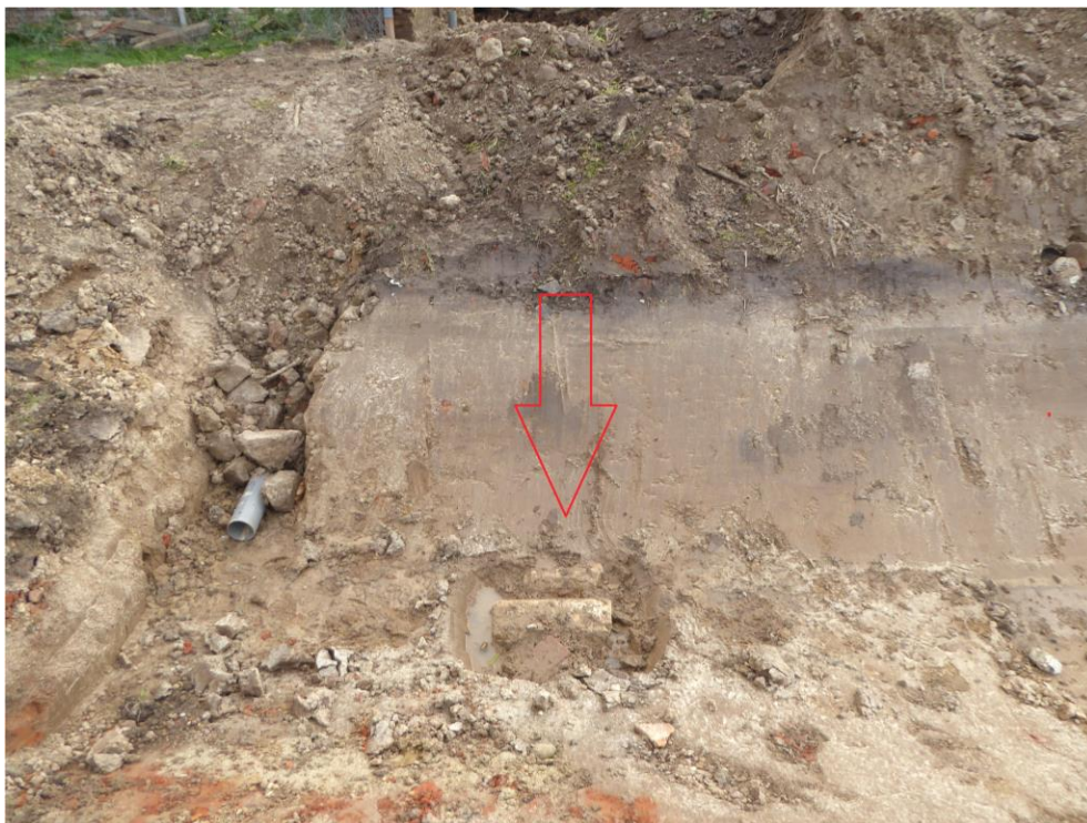
Figuur 63: De aangetroffen stenen onderaan de uitgegraven gracht (© agentschap Onroerend Erfgoed).
