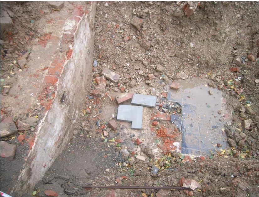
Figuur 14: Aangesneden gebouwrestanten in baksteen en een vloerniveau bestaande uit zwarte tegels. Zicht naar noorden (© agentschap Onroerend Erfgoed).
