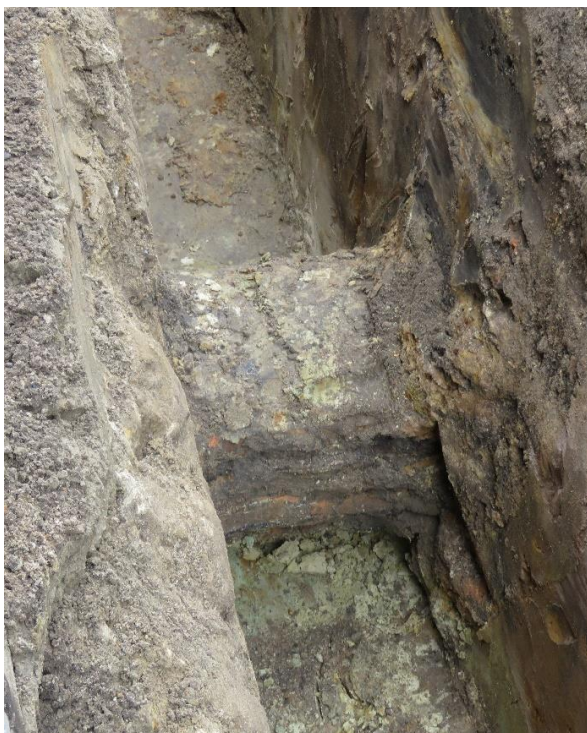
Figuur 72: De muurstructuur ter hoogte van huisnummer 22. Gefotografeerd richting westen.
