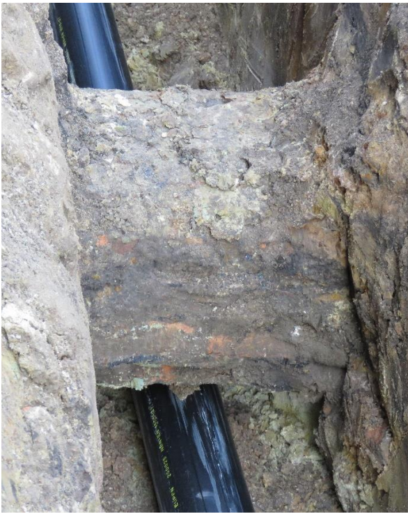
Figuur 74: De manier waarop de kabels en leidingen onder de muurstructuur ter hoogte van Advokaatstraat 22 werden getrokken.
