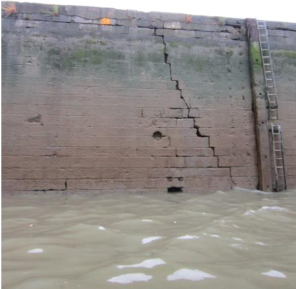
Figuur 25: De slechte toestand van de kaaimuur voor de huidige werken (Technum en SBE (red.) s.d.: 22, fig. 22).
