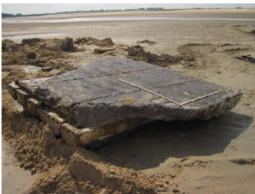
Figuur 121: Het betonplatform van locatie 1 (© agentschap Onroerend Erfgoed).
