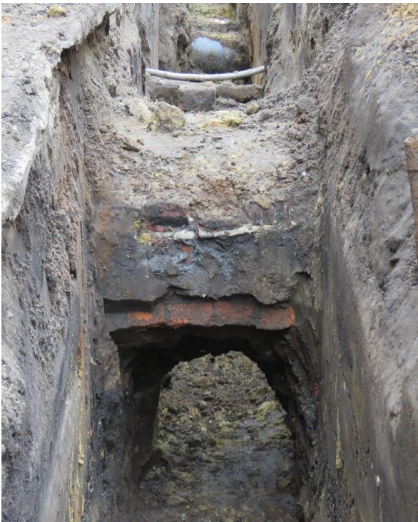
Figuur 76: Detailopname van de muurstructuur ter hoogte van huisnr. 30/32.
