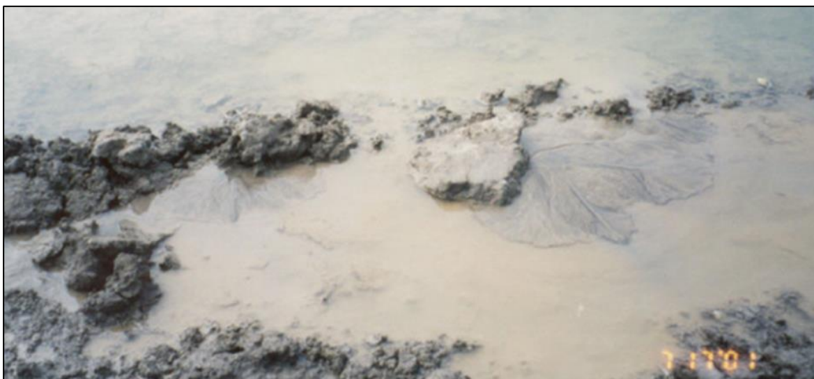
Figuur 34 opbarsten van de bouwputbodem, met het ontstaan van 'bronnen' en zandtransport
