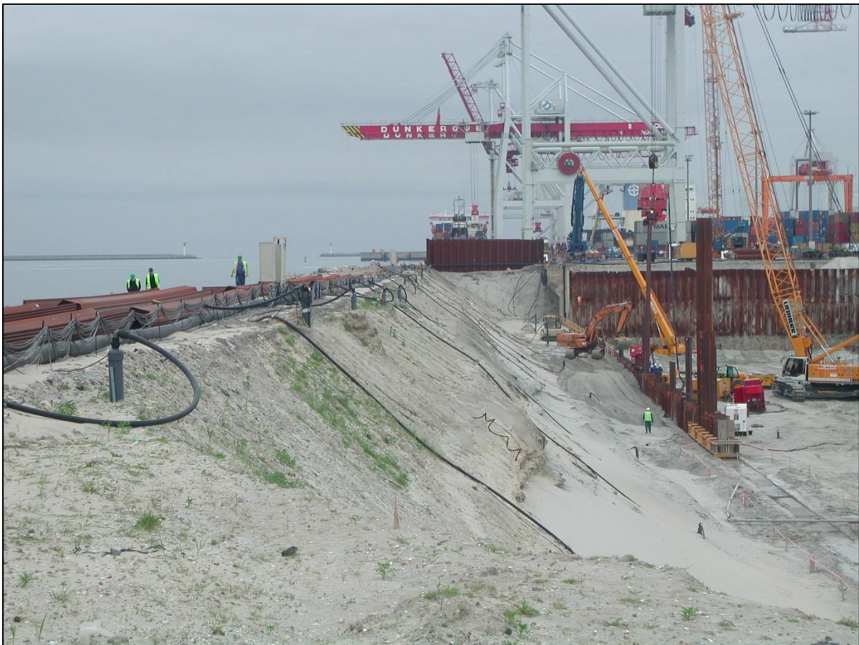
Figuur 32 uitvoering van een bemaling met dieptebronnen
