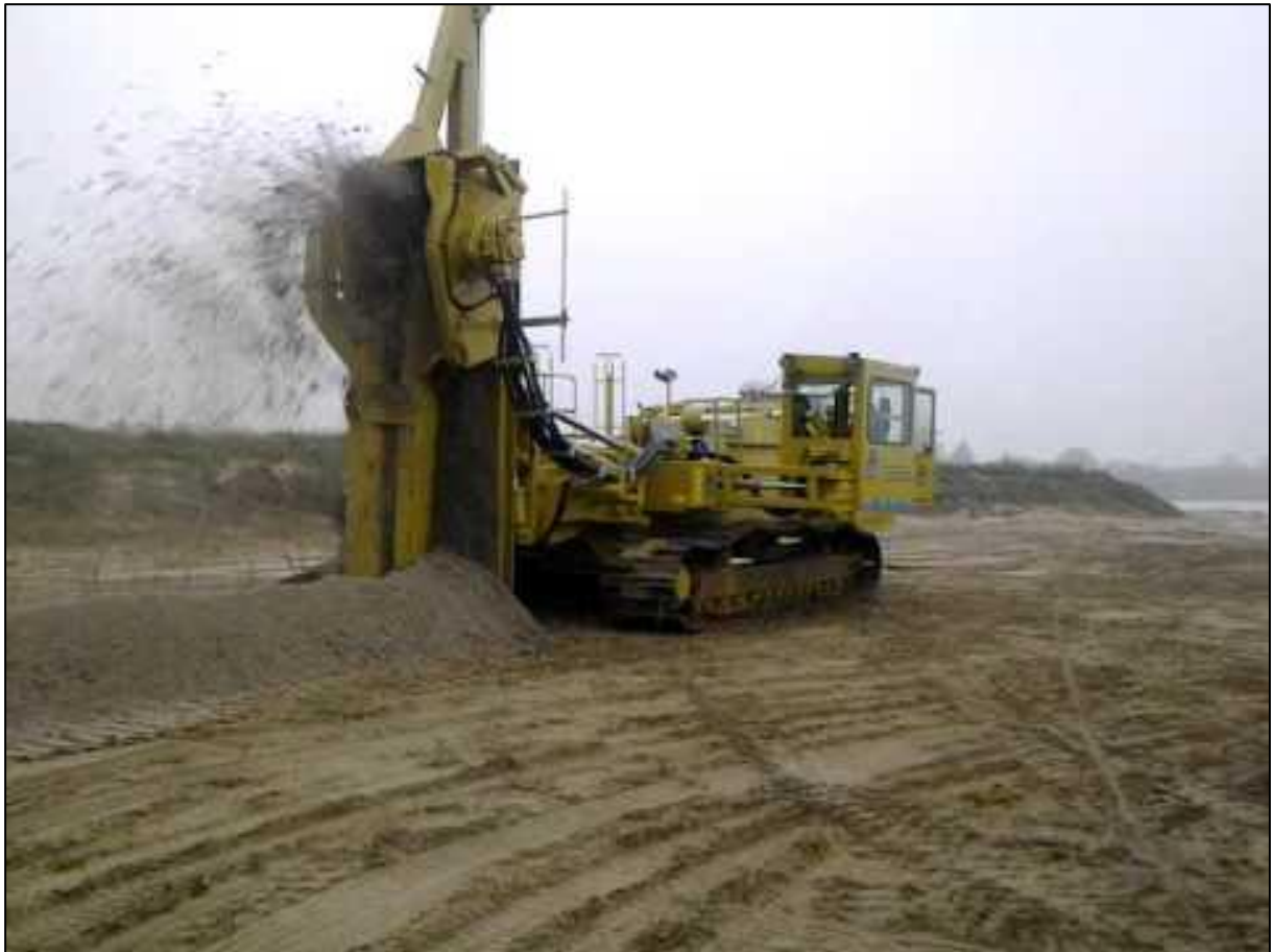
Figuur 20 kettinggraafmachine aan het werk
