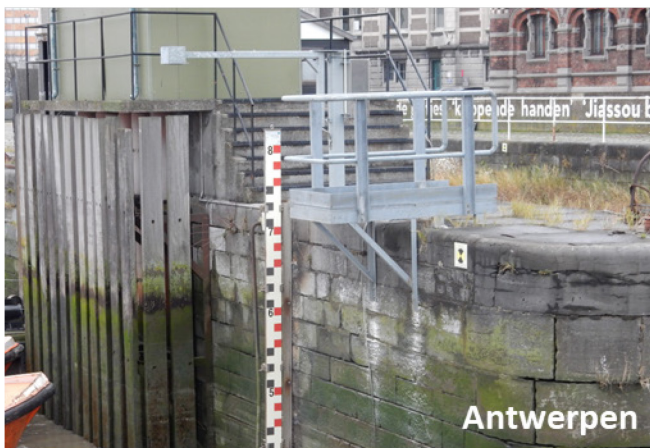
Figuur 2 – Opstelling radar voor de getijposten Antwerpen en Prosperpolder
