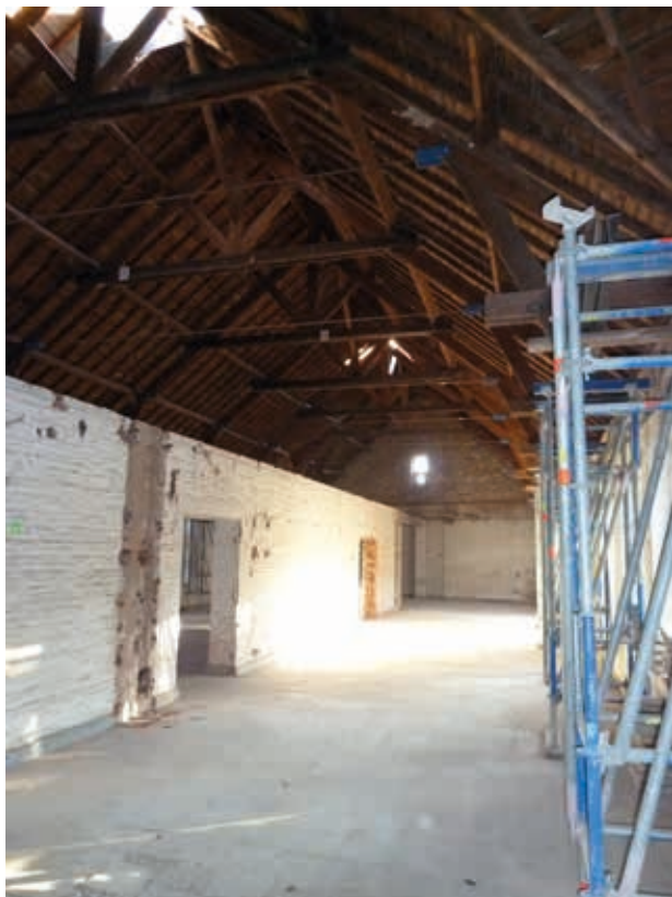
▲ Houtmuseum - afbraak van het plafond. Foto Danny Swaerts.
