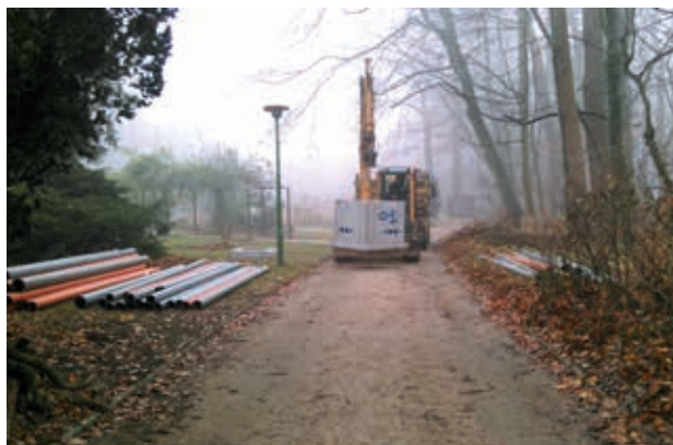
▼ Voorbereidende werken voor het nieuwe rioleringsstelsel. Foto Dirk Reusens.
