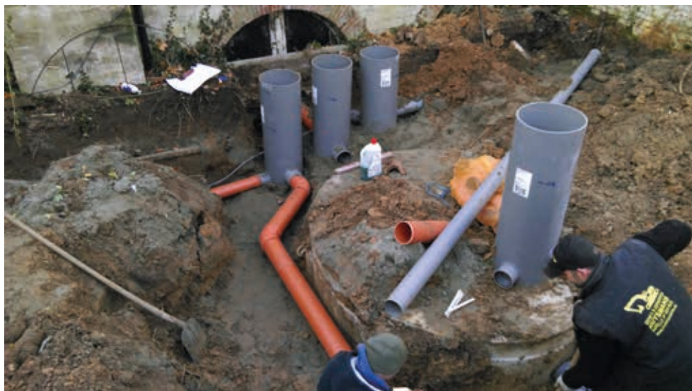
▲ Installatie van het nieuwe systeem. Foto Dirk Reusens.
