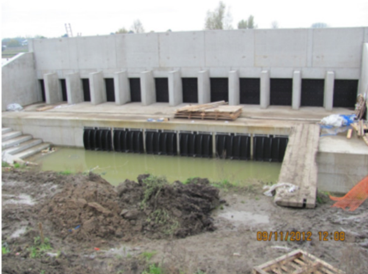
Figuur 3 – Zicht vanop de vroegere Scheldedijk op de in- en uitwateringsconstructie met bovenaan de inlaatkokers (12) en onderaan 6 uitwateringskokers met terugslagklep.
