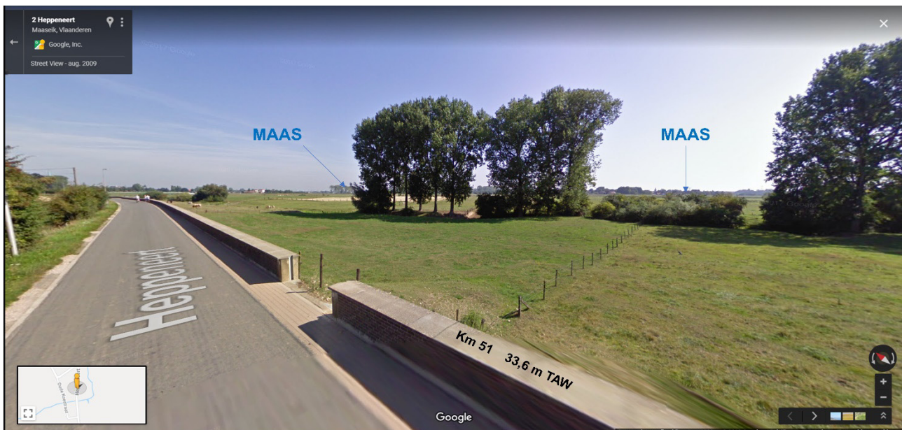
Figuur 1 Voorbeeld van een opening in de dijkmuur die de dijkhoogte bepaalt nabij Heppeneert. (foto Google streetview)
