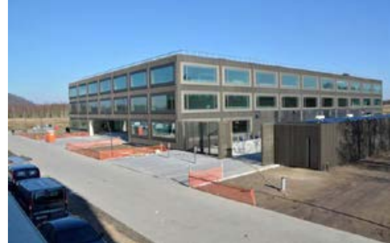
EnergyVille (Genk) in aanbouw
