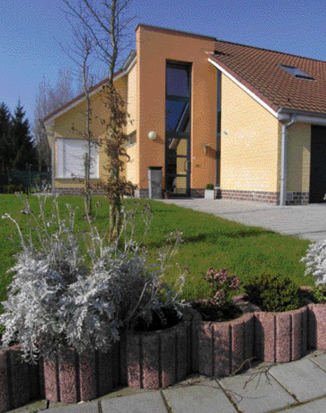
SHM Eigen Haard - Maelstede, Sint-Amansdijk in Kerkhove, 14 huurwoningen, pilootproject levenslang wonen
