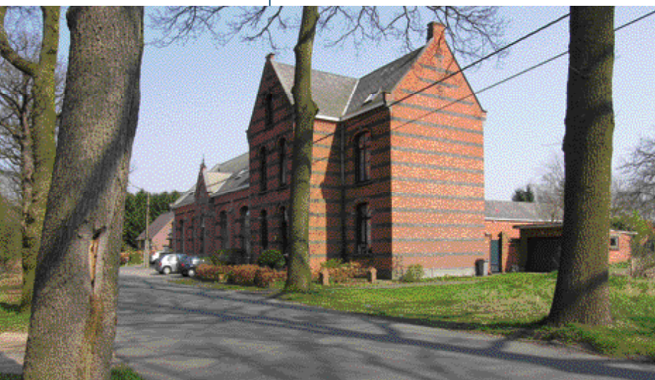
SHM Molse Bouwmij. voor de Huisvesting - Schooldreef in Rauw, renovatie van oude gemeenteschool tot 8 appartementen
