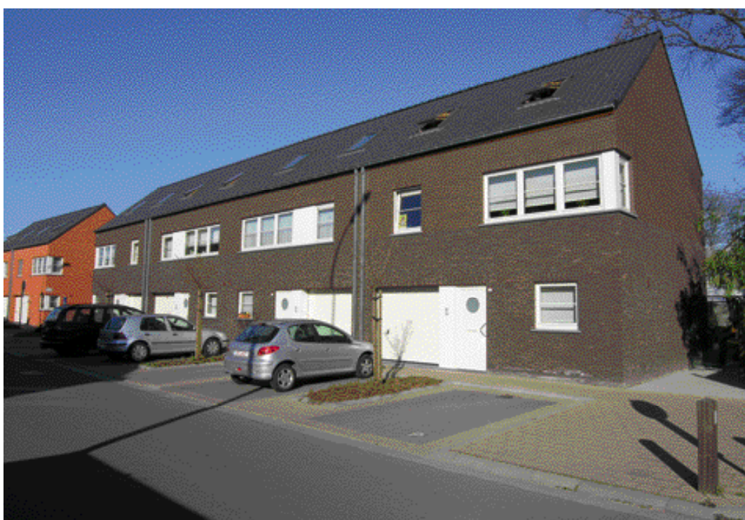
SHM Gewestelijke Maatschappij voor Woningbouw - Elststraat in Zele, nieuwbouw van 19 woningen
