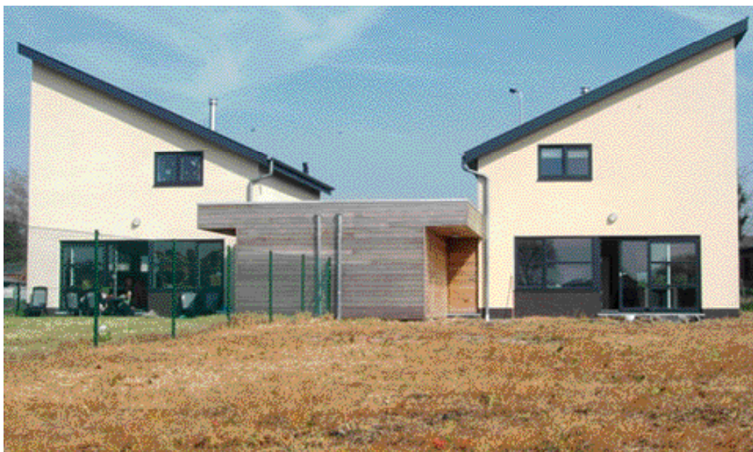
SHM De Nieuwe Haard - Kersenstraat in Ronse, nieuwbouw van 7 koopwoningen
