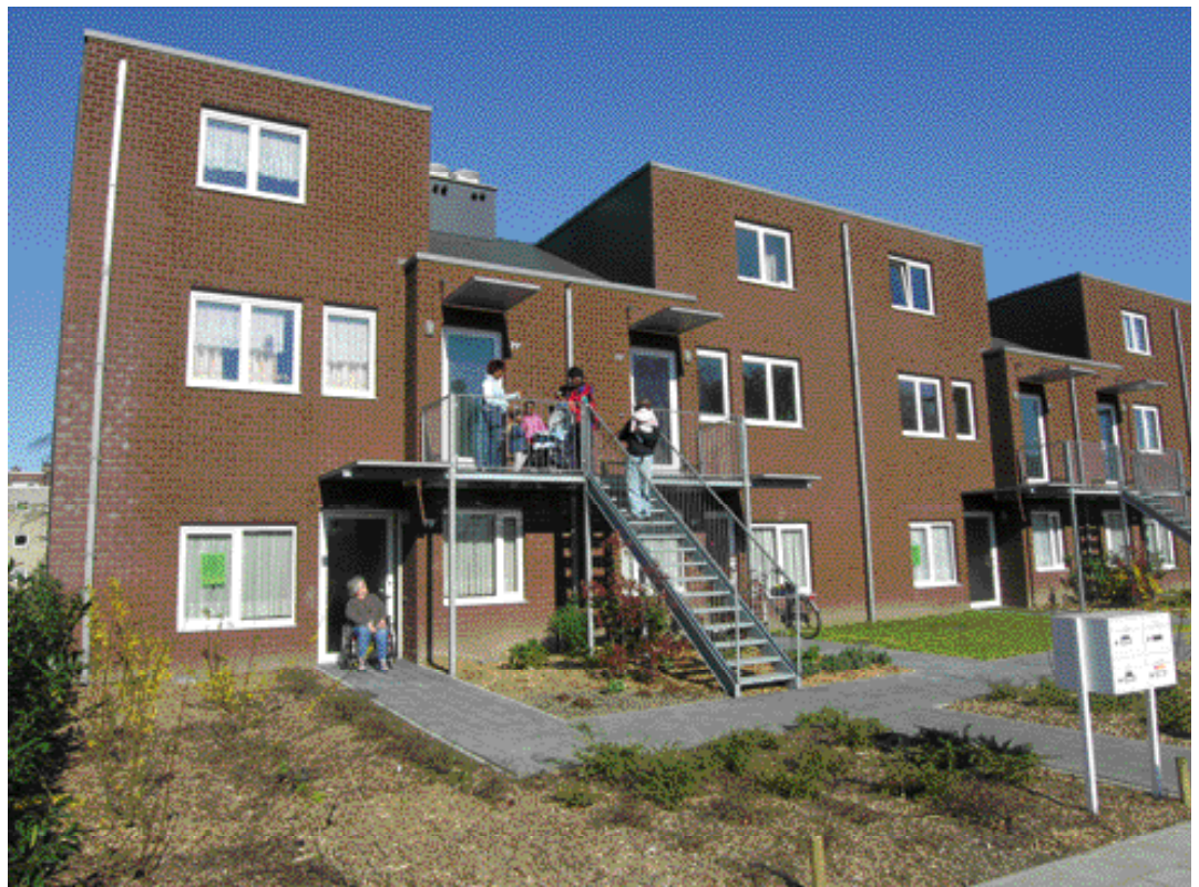
SHM De Ideale Woning - Spoorwegstraat in Berchem, nieuwbouw van 10 huurappartementen, pilootproject levenslang wonen
