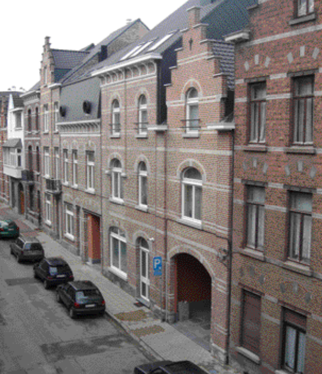
SHM Nieuw Sint-Truiden - Spoorwegstraat in Sint-Truiden, verbouwing van 4 woningen en fabriekspand tot 16 huurappartementen
