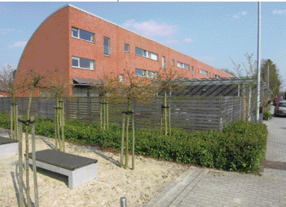
SHM Zonnige Kempen - Negenbunders in Booischoot, nieuwbouw van 12 woningen + renovatie van 8 appartementen
