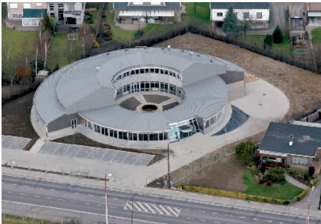
SHM Providentia – Brusselsesteenweg in Asse, nieuwbouw van 7 app. + kantoor
