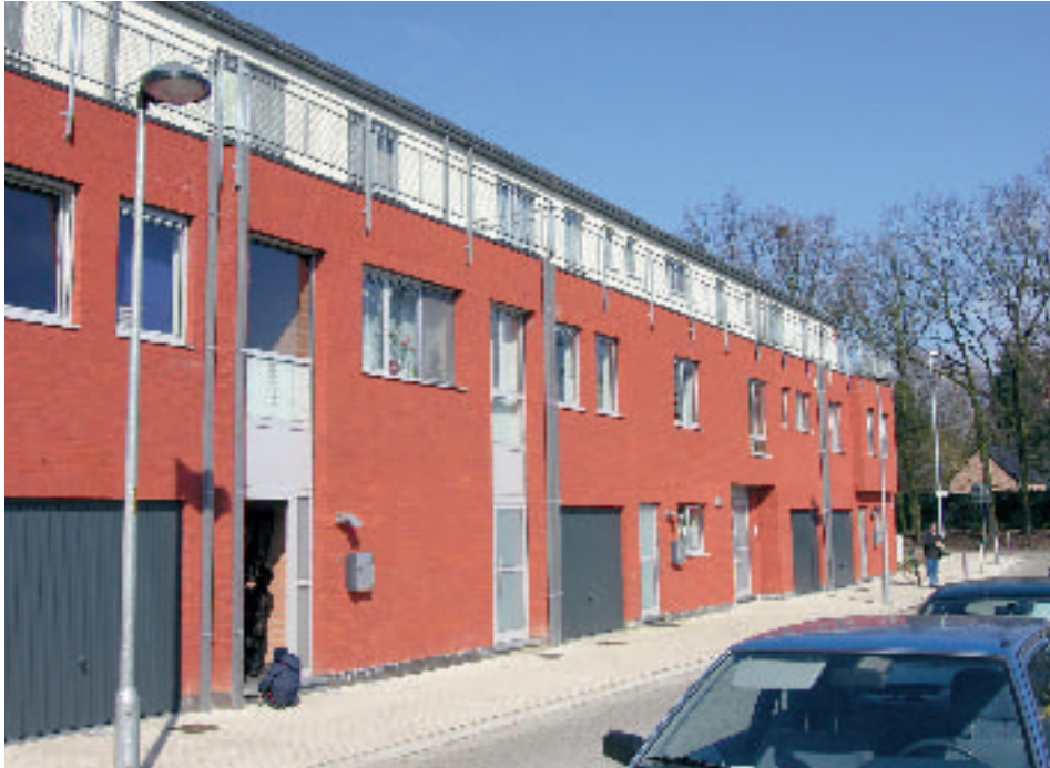
SHM Mij. voor de Huisvesting van het kanton Heist-op-den-Berg – Cardijnwijk in Heist-op-den-Berg, nieuwbouw van 28 woningen
