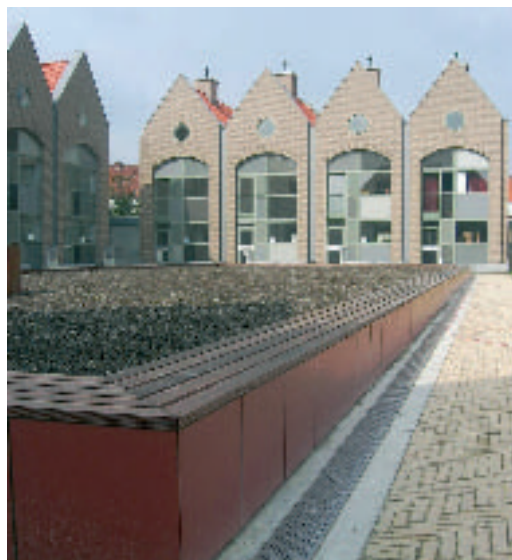
SHM Zuid-West-Vlaamse Sociale Huisvestingsmaatschappij – TSA, Elfde Julilaan – H. Verriestlaan in Kortrijk, vervangingsbouw van 33 koopwoningen + 45 garages
