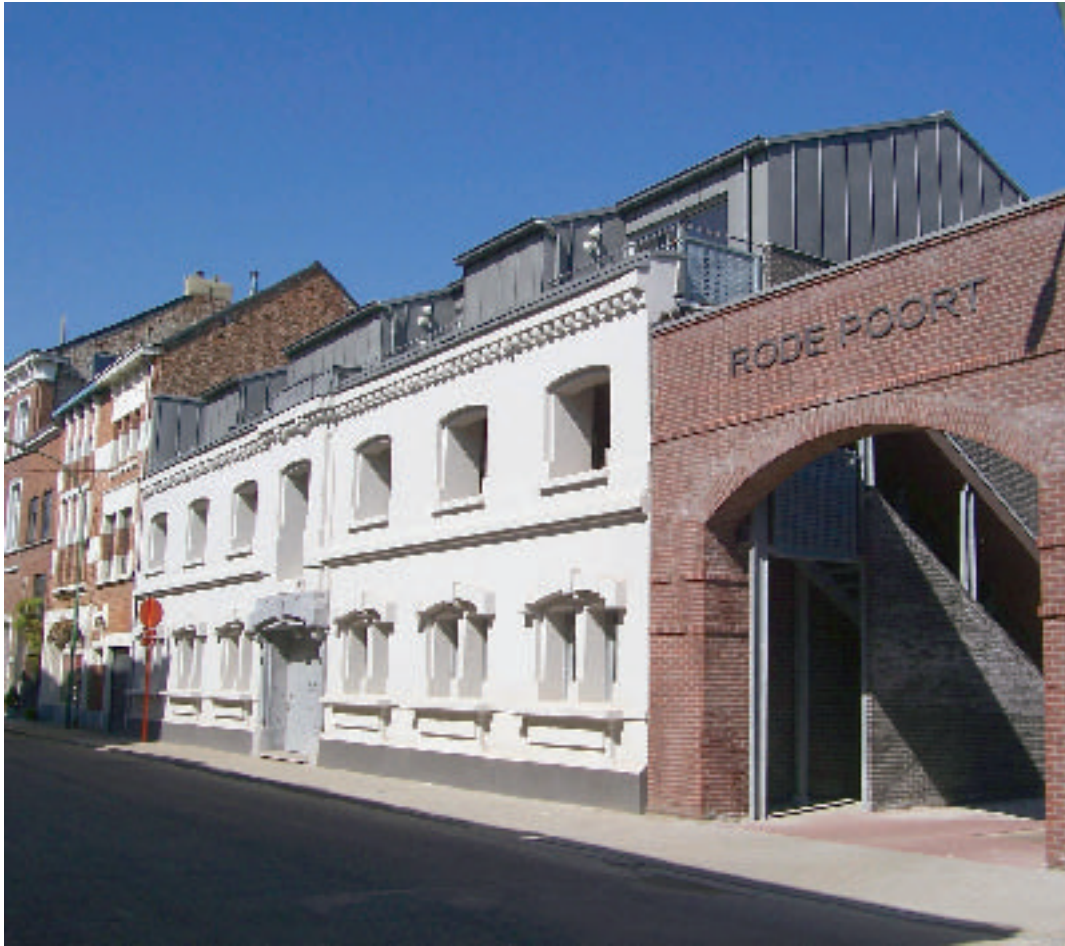
SHM Huisvesting Tienen – Rode Poort, Donystraat in Tienen, vervangingsbouw van 9 woningen + 6 app.
