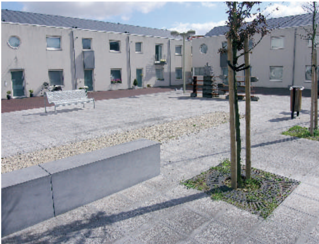
SHM Huisvestingsmaatschappij voor Midden West-Vlaanderen – Nederweg in Izegem, vervangingsbouw van 14 huurwoningen + 5 koopwoningen
