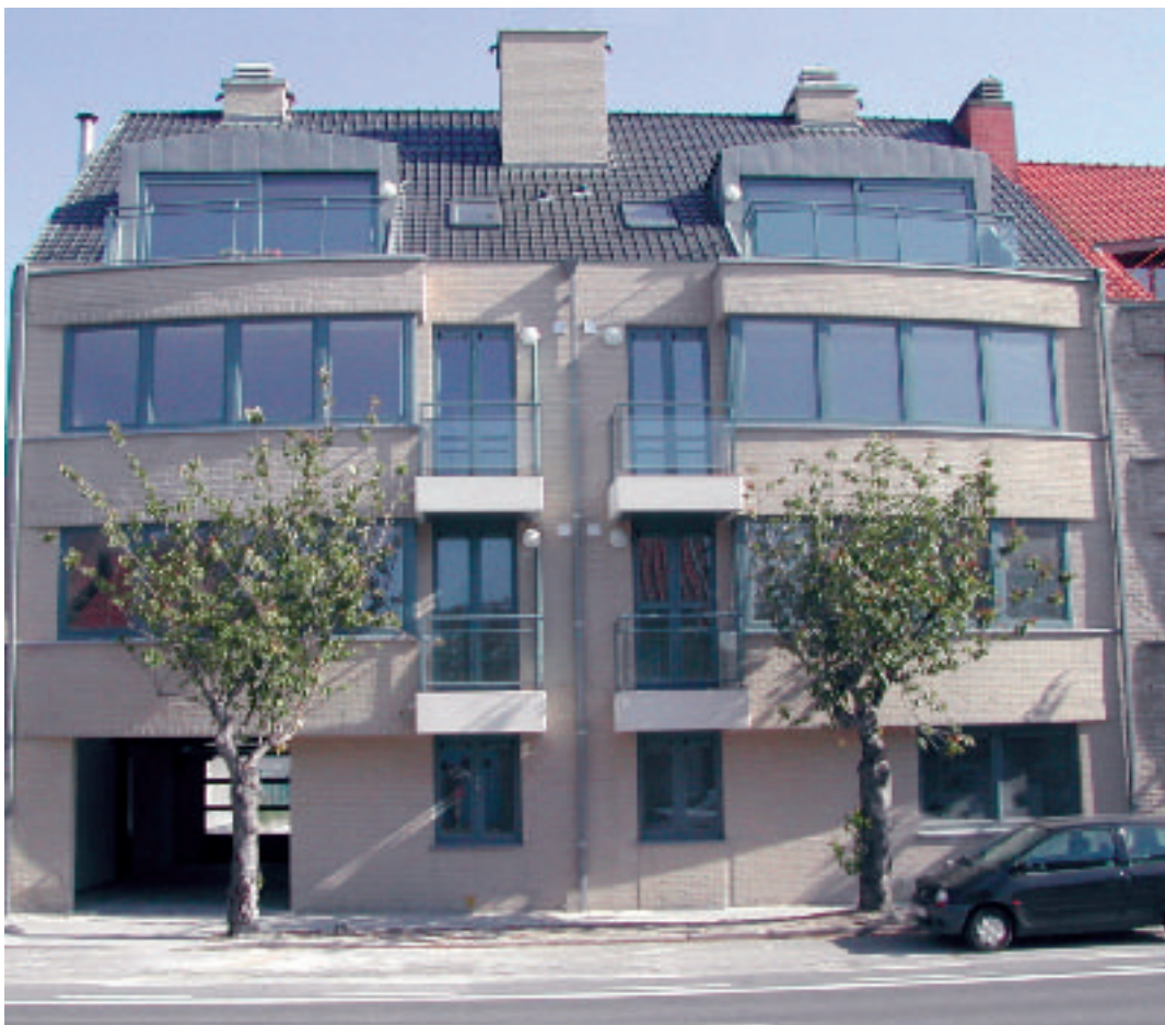
SHM Veurnse Bouwmaatschappij – Veurnestraat in De Panne, nieuwbouw van 8 app.
