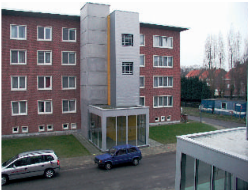
SHM Goed Wonen.Rupelstreek – Vlierlaan in Boom, renovatie van 48 appartementen
