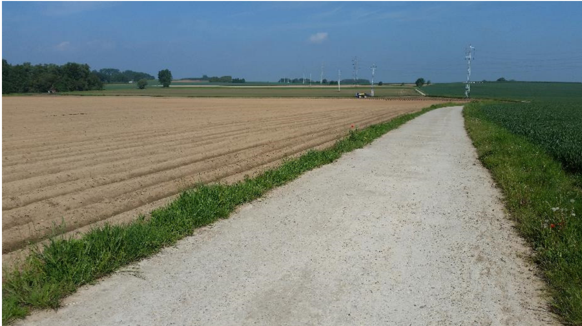
Figuur 58: Bermen worden te kort tegen de weg omgeploegd. Vissenaken Zuid, 26 mei 2016 (foto: Griet Nijs)
