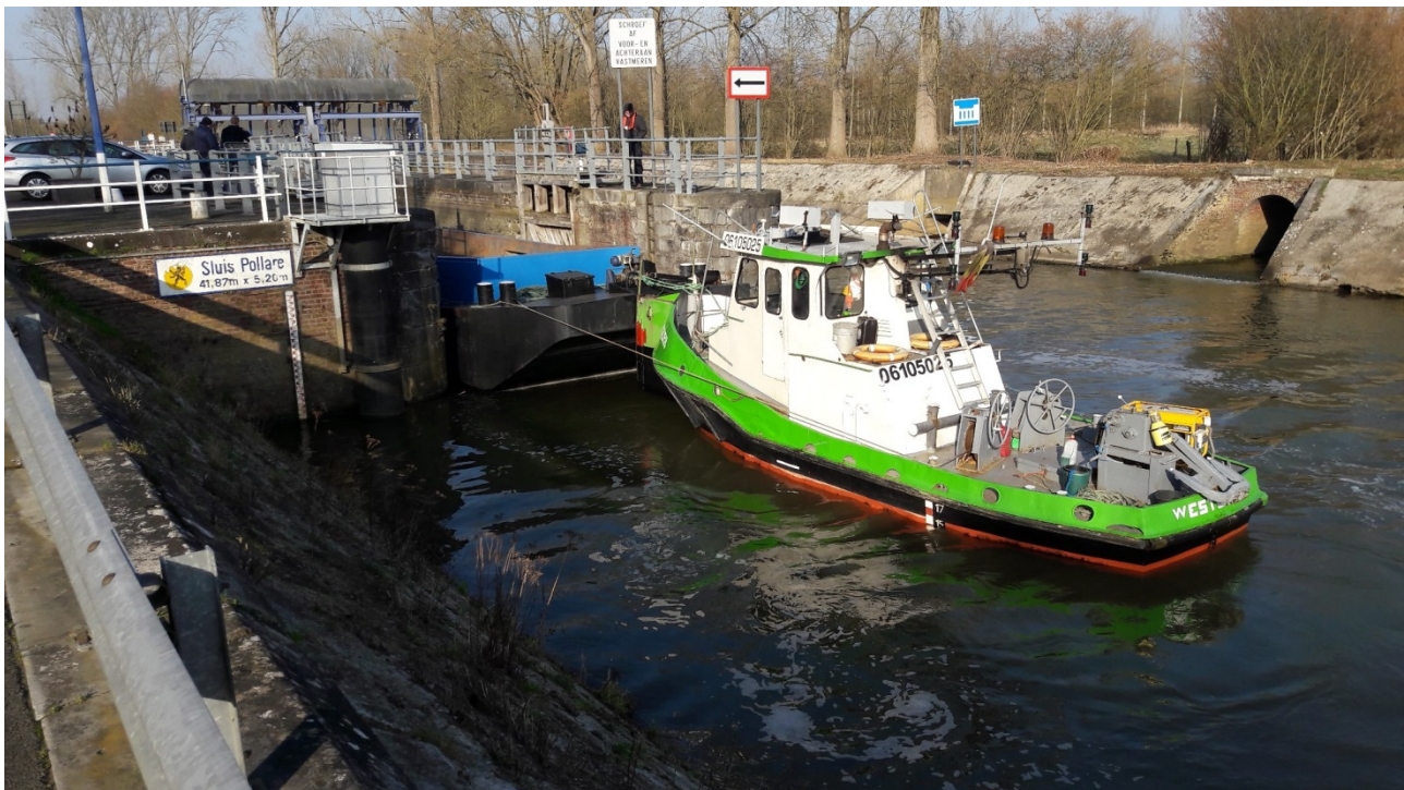
Figuur 10 – Invaren van de sluis te Pollare met een duwcombinatie
