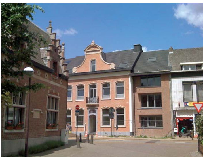
SHM Zonnige Kempen Nijlen Kessel Kesseldorp – 16 sociale woonegelegenheden (nieuwbouw en renovatie) architect Martine Van Noten/aannemer Lamers NV
