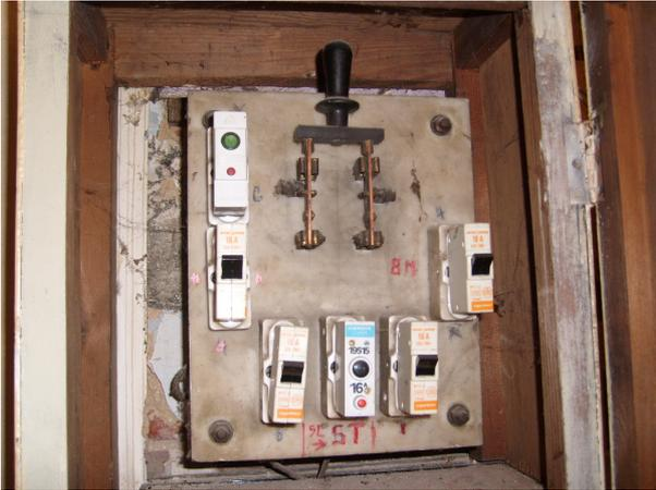
Foto links: niet afgeschermd messchakelaar (elektrocuciegevaar).
