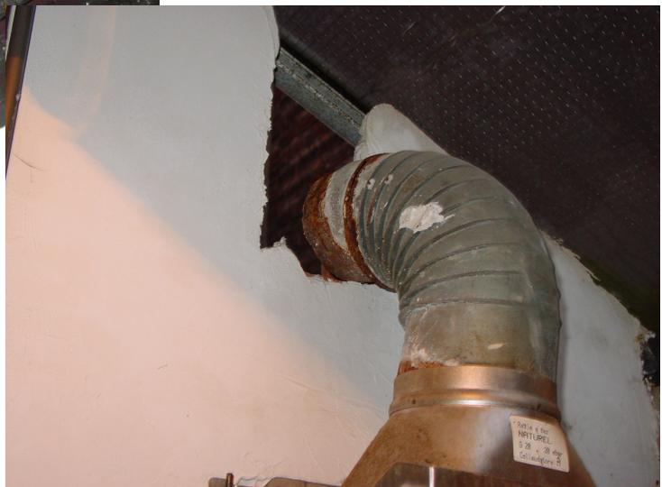
Foto rechts: afvoer van de gasgeiser onvoldoende verdicht, waardoor de verbrandingsgassen terug in de kamer kunnen komen.
