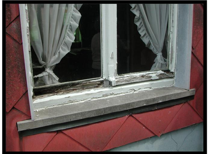
Ontbrekende raamkruk: het raam gaat niet meer open, waardoor de ruimte ook niet kan verlucht worden.
