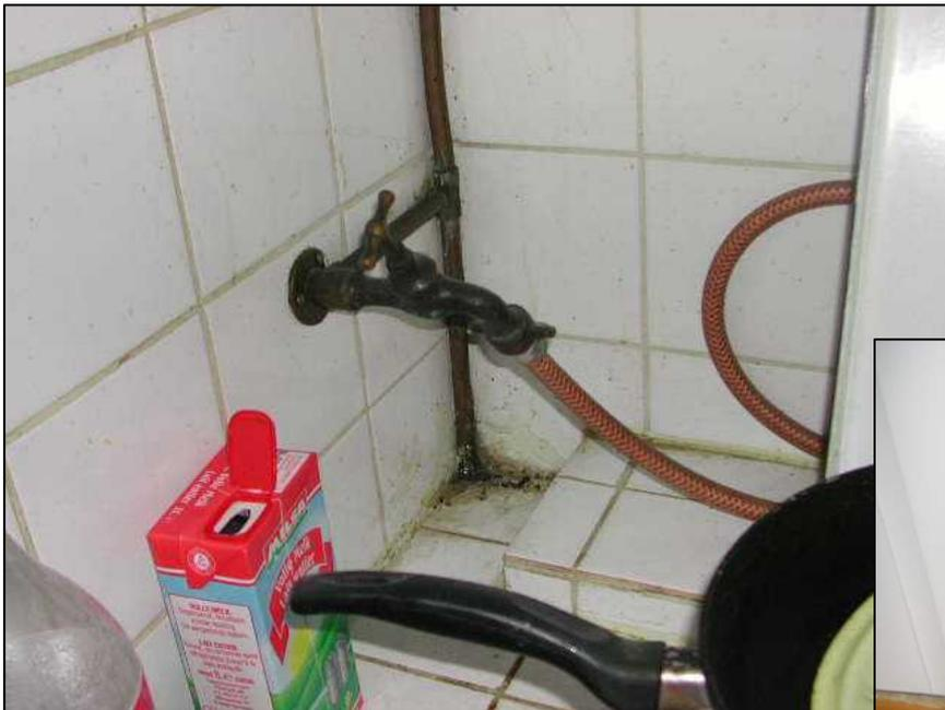
Links: aansluiting van het gasfornuis (gebruik van waterkraan en tuinslang op een gasleiding).
