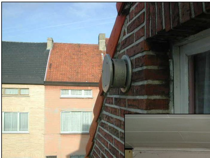
CO-gevaar: de afvoer moet minstens 1 meter boven de hoogste dakrand uitkomen om de trek te bevorderen. Indien niet, kunnen de verbrandingsgassen bij turbulente luchtstromingen terugslaan.
