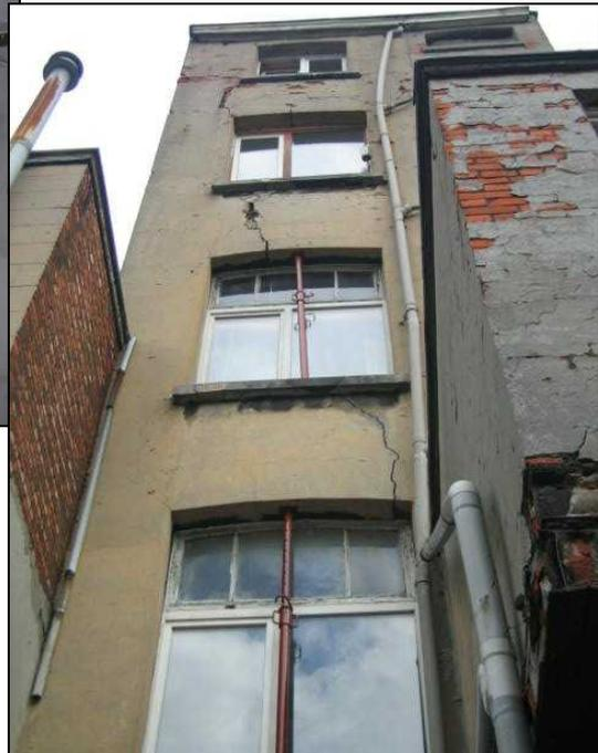
Rechts: scheurvorming in de achtergevel.
