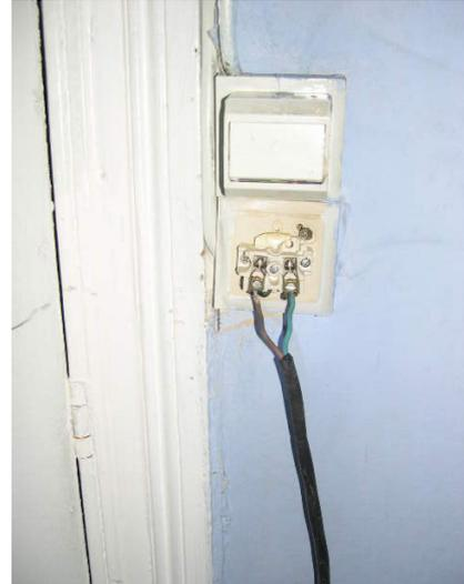
Foto links: stopcontact zonder afdekplaatjes (afdekplaatje plaatsen).
