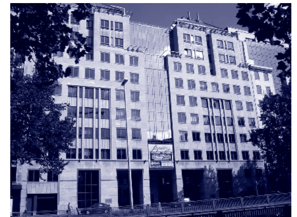
De kantoren in het Artemisgebouw in de Kunstlaan
