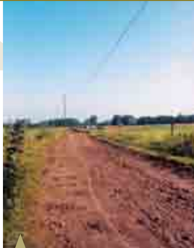
Het platteland moet niet enkel leefbaar, maar ook be-leefbaar zijn. De nieuwe wegen in Zondereigen zijn fiets- en wandelvriendelijk en kunnen op die manier een bindmiddel zijn tussen landbouwer en recreant.
